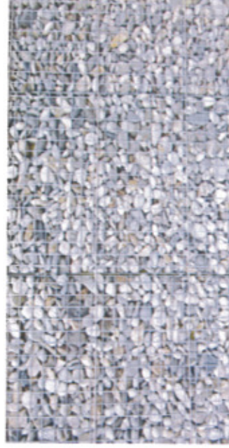
Muret en gabions - ZA de Volzac à Saint-Flour - S. Teyssou architecte
