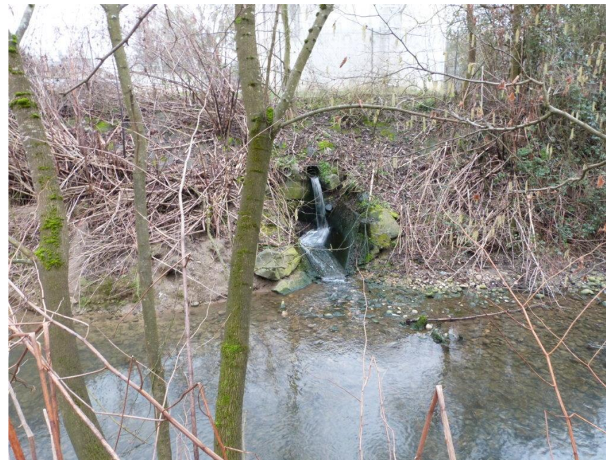
Sortie des eaux de la STEP de Misérieux
