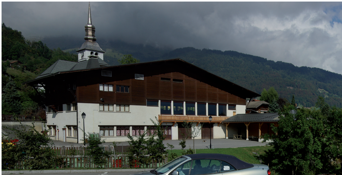
Un vaste bâtiment 'salle des fêtes' directement à côté du pré de foire.
