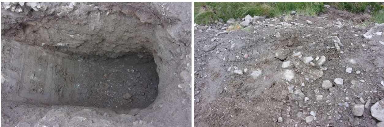
Puits à la pelle au niveau du bâtiment
