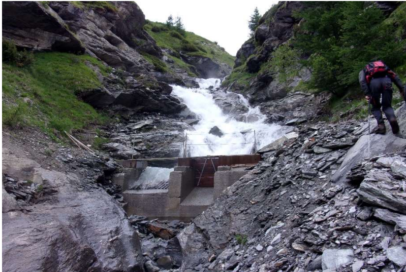
Passage piéton sur prise d'eau EDF
