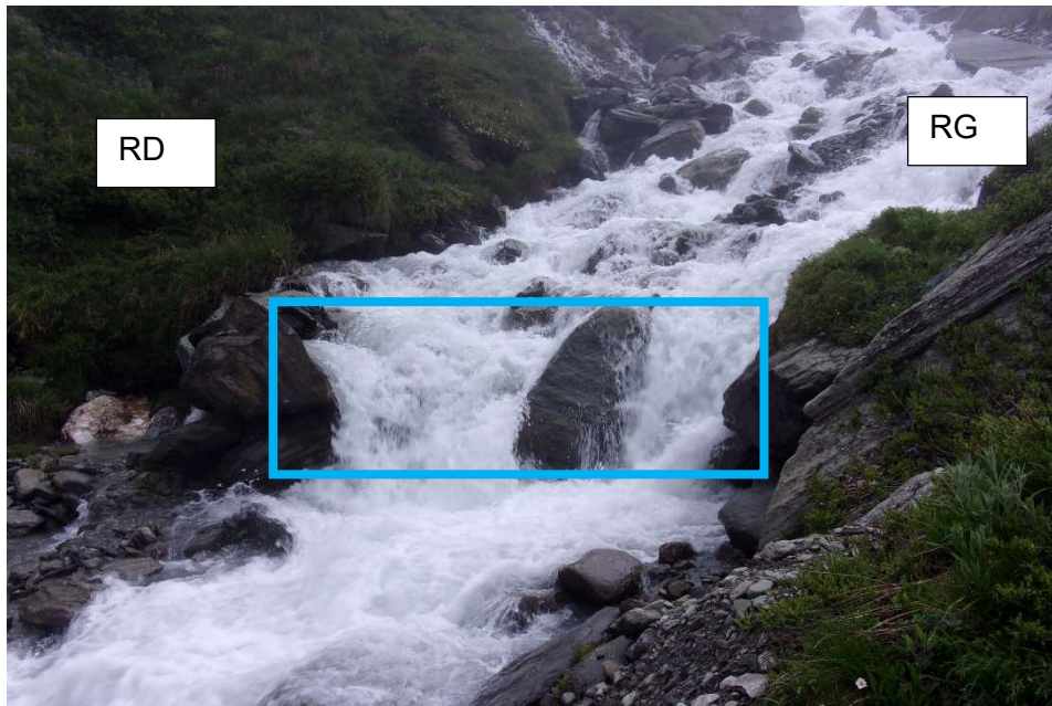
Implantation de la prise d'eau
