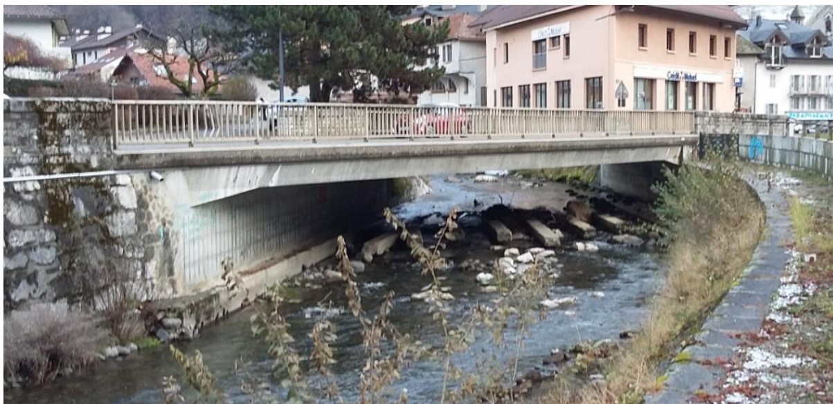
Photo 8 : Radier du Pont Neuf
