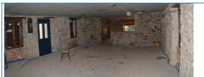
Intérieur rez de chaussée. Murs pierres, menuiseries bois, cheminée
