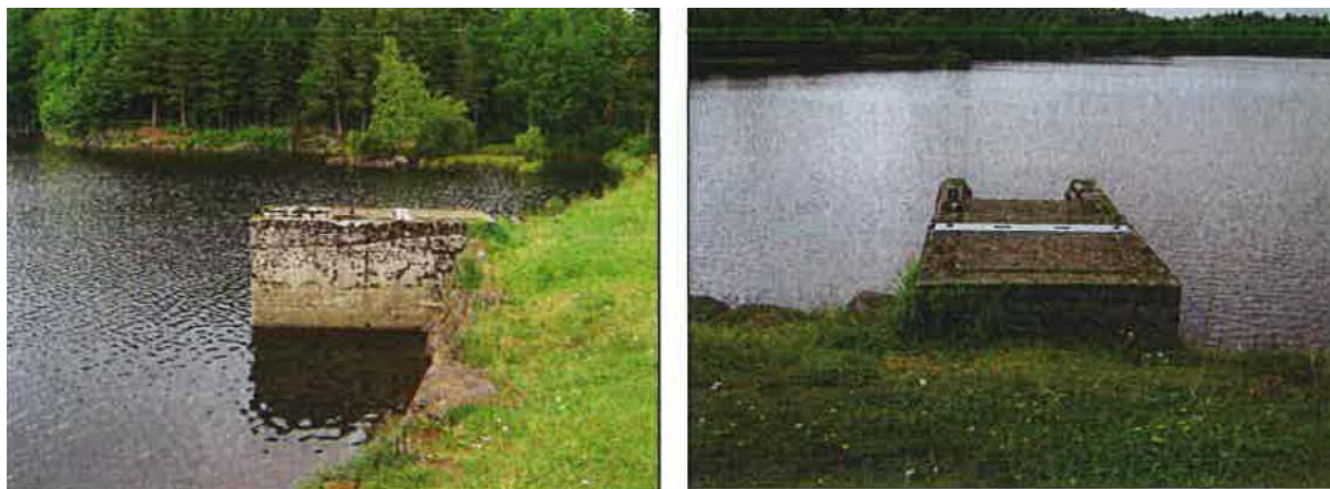
Vues du moine de côté et de la digue (photos SAFEGE)
