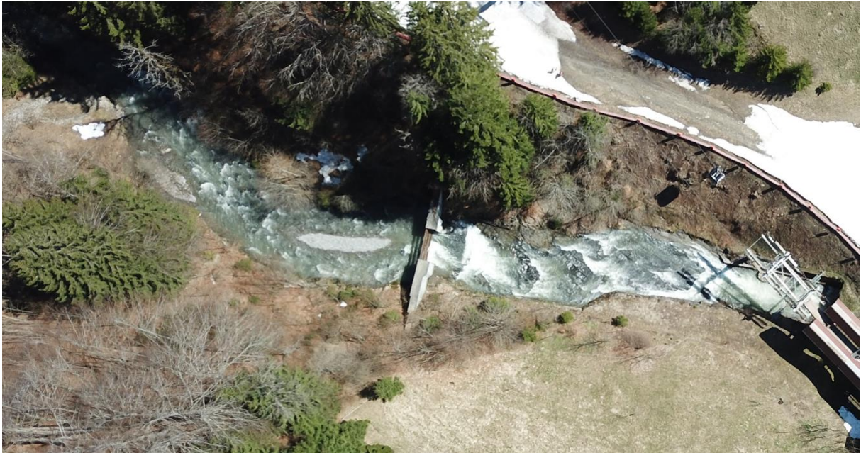
Photo 15 : Petite plage de dépôt en amont du dalot des télécabines.
