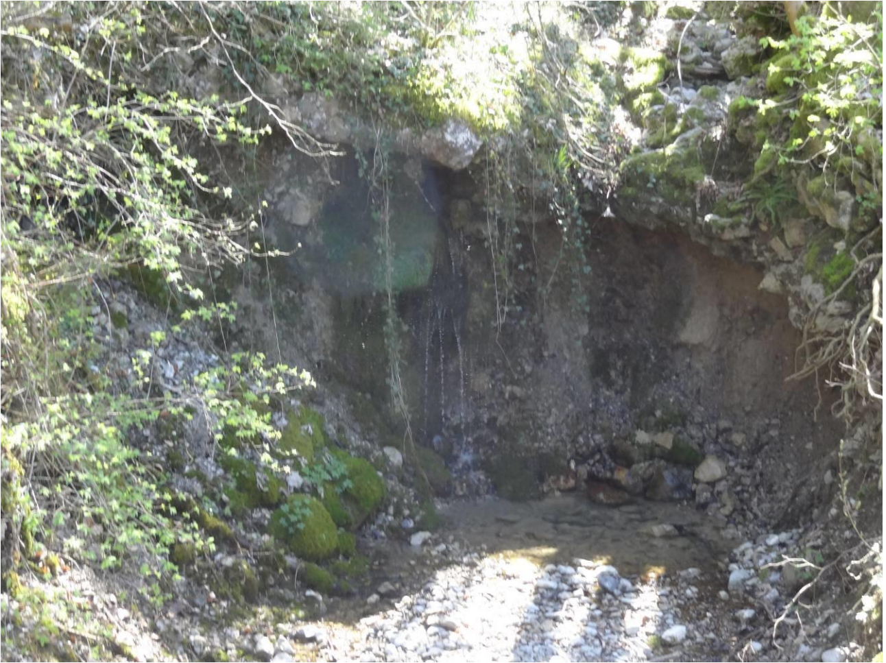
Photo 29 : Déstabilisation du lit dans la zone de curage en amont du busage.
