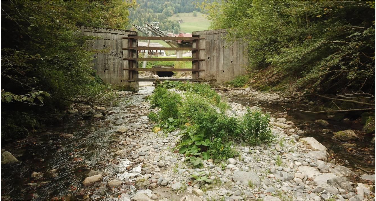
Photo 16 : Plage de dépôt et entrée du dalot amont.
