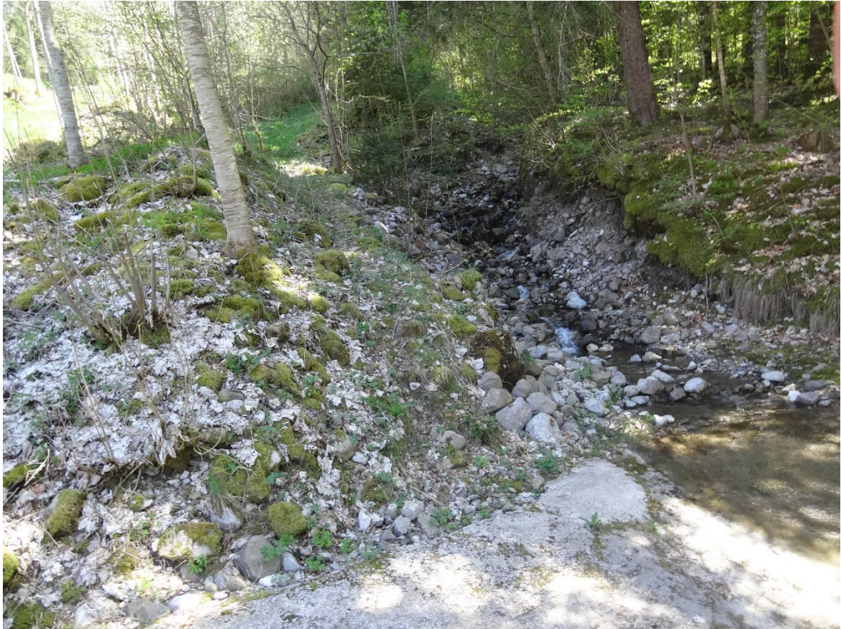
Photo 24 : Passage à gué insuffisant du Ruisseau des Combes en amont de la Ville.
