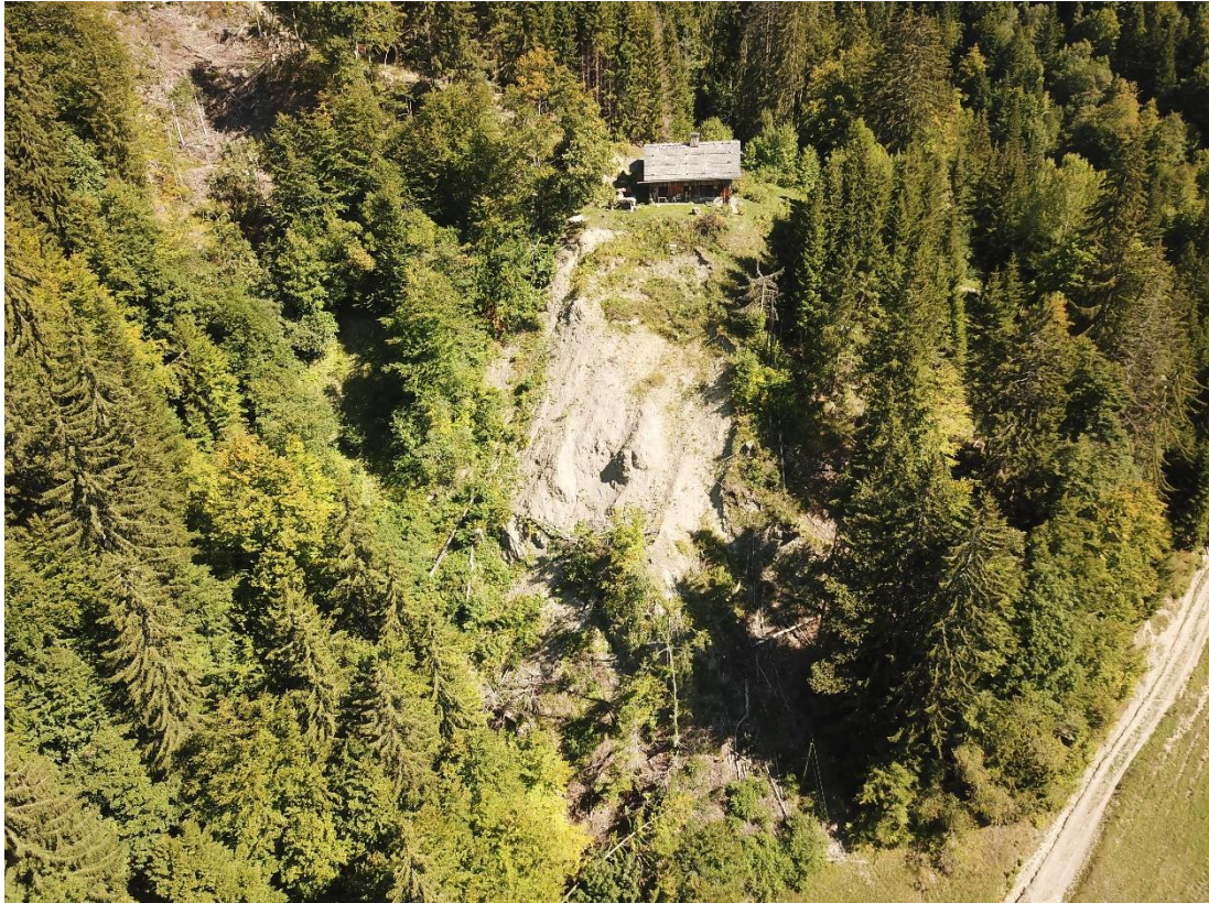
Photo 3 : Glissement de terrain du ruisseau des Poches.
