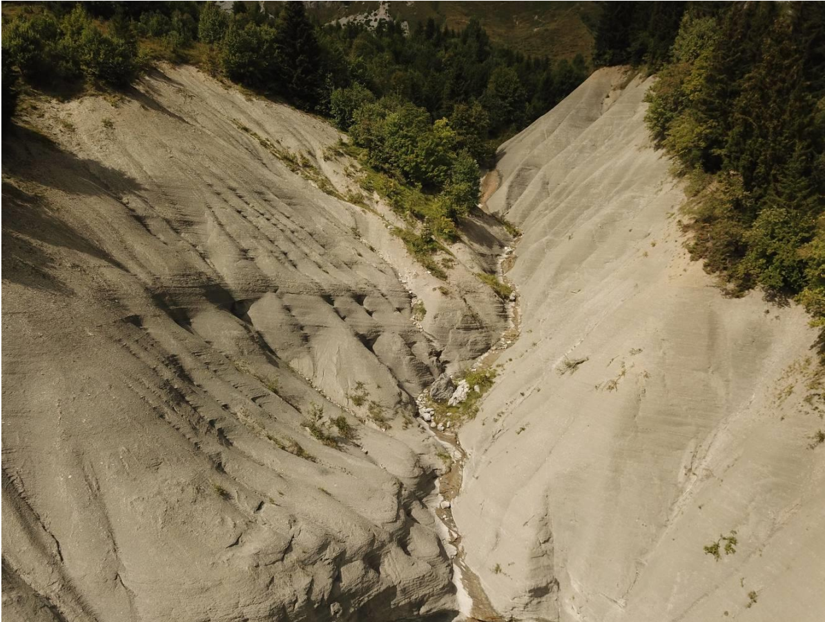
Photo 11 : Érosions de grande extension en amont du Chinailon.
