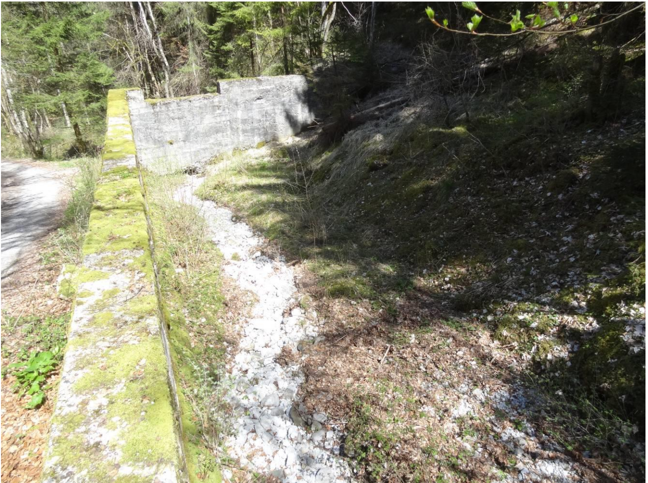
Photo 28 : Ouvrage entretenu de régulation du Ruisseau de Gratty.
