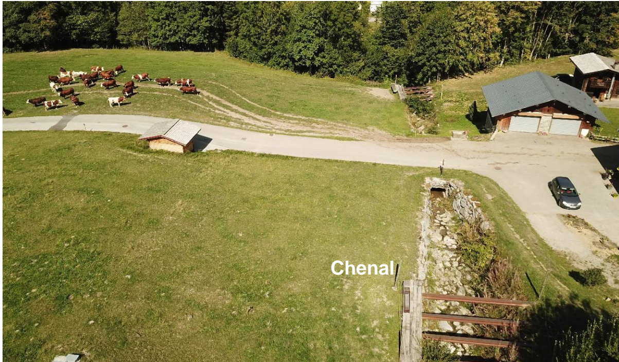
Photo 6 : Aménagement du ruisseau du Pessey avec un chenal large.
