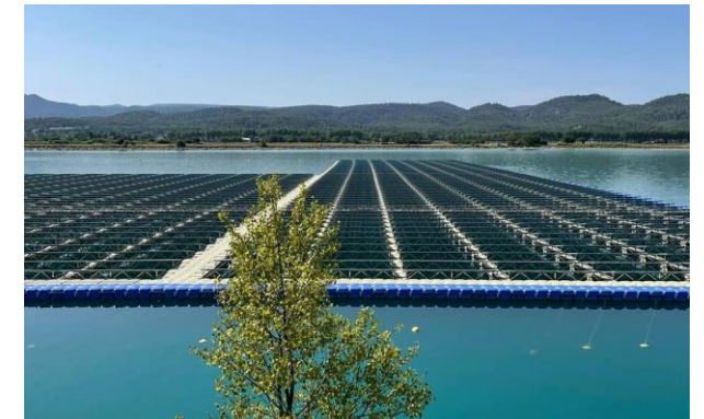
Peyrolles-en-Provence (2021) Ancienne gravière – 14.7 MWc
