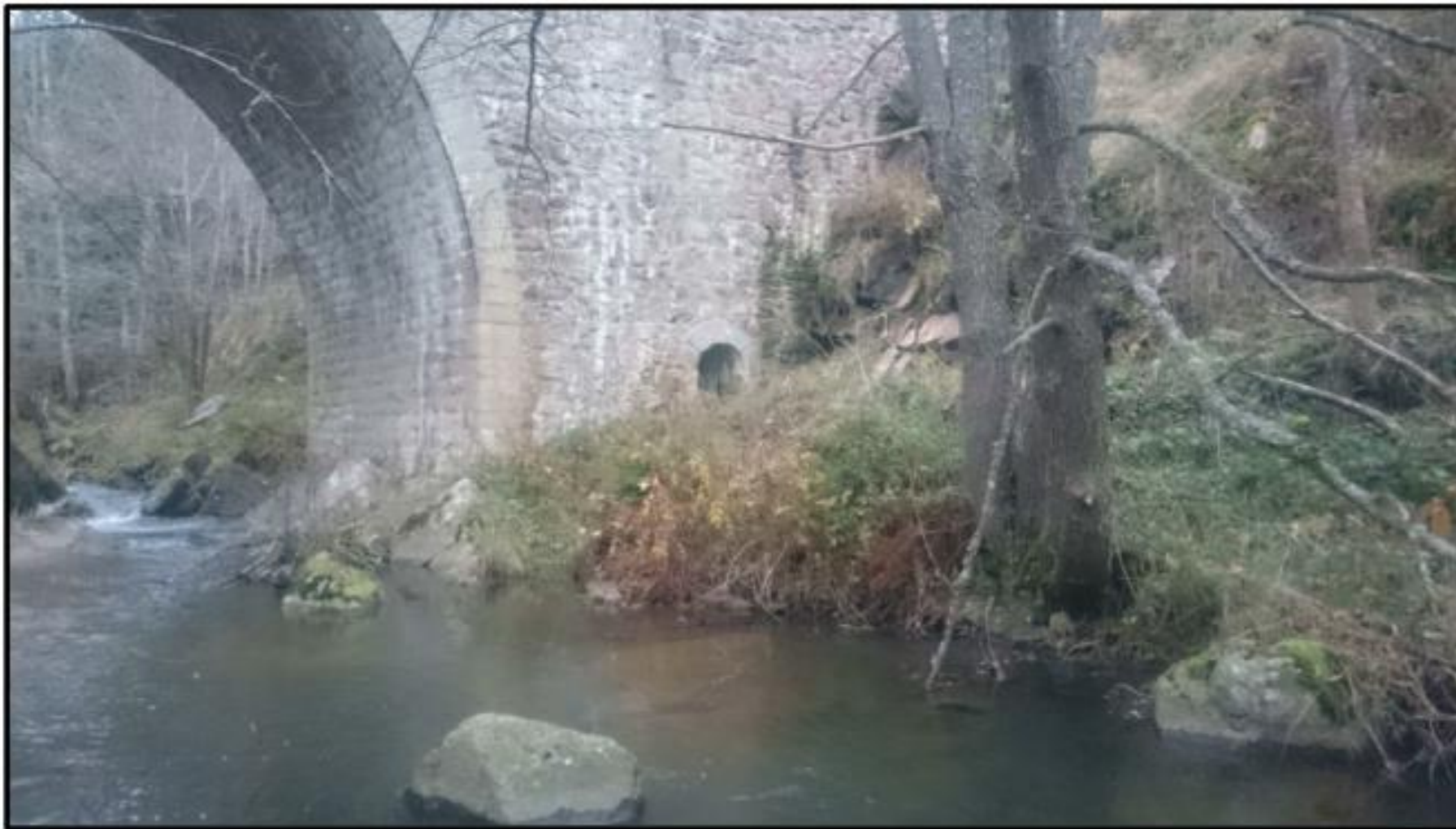
Figure 2 : Réserve pour le canal déjà existante dans la pile du Pont – vue aval
