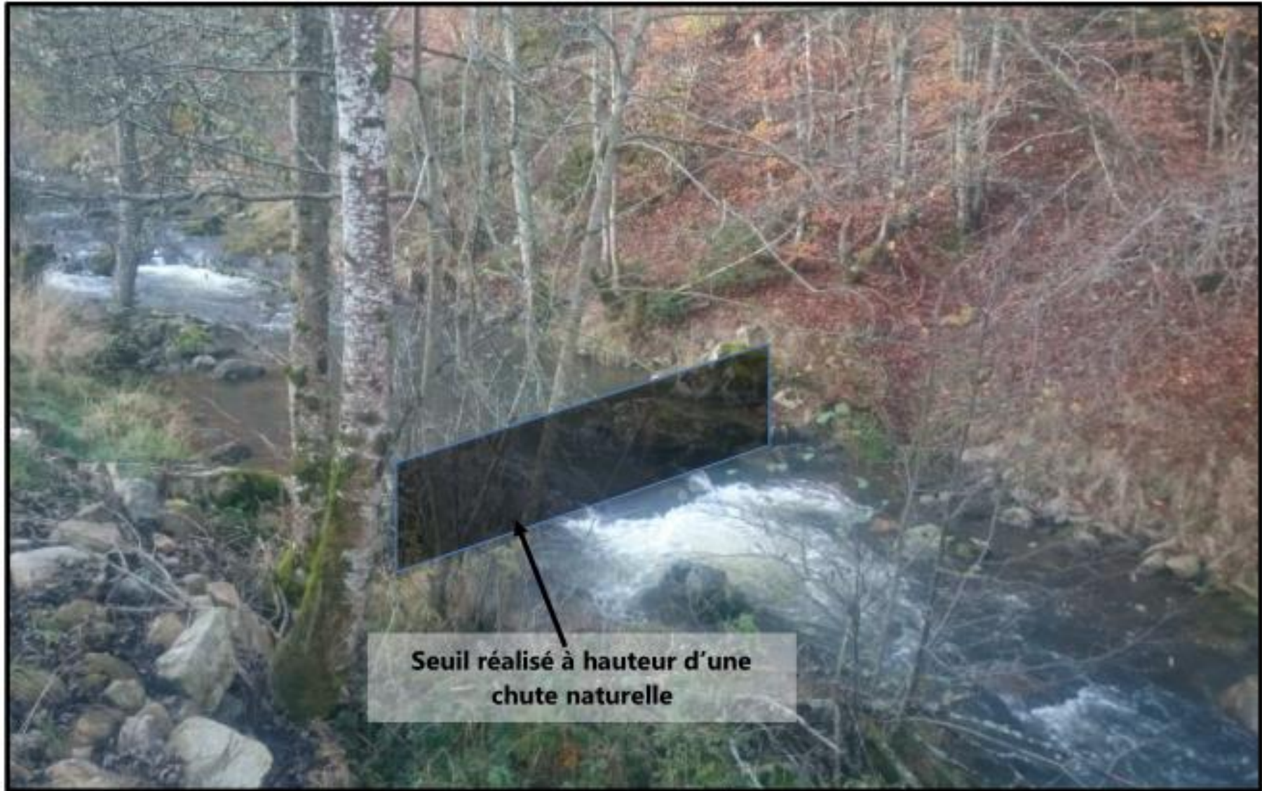
Figure 1 : Emplacement du seuil de la MCHÉ du Pont du Fraysse
