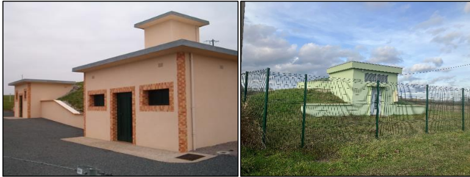
Réservoir de Bellevue / réservoir des Ardelles
