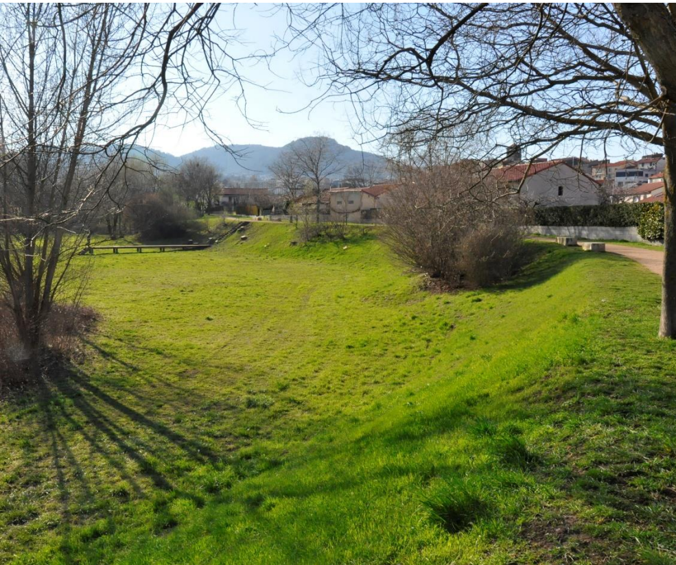
Bassin d'orage (commune de Beaumont)
