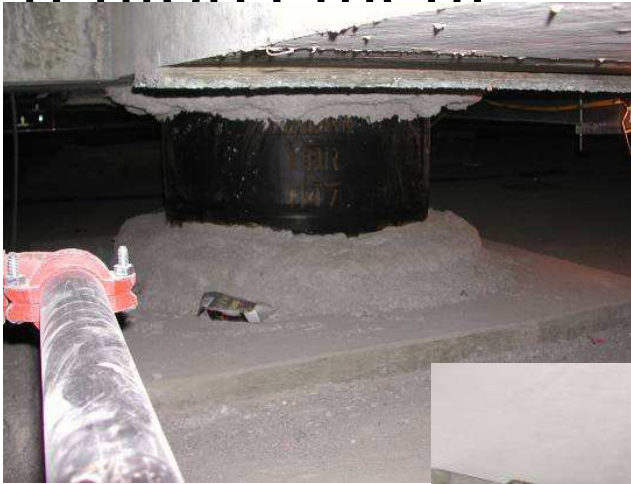
Isolateur parasismique
