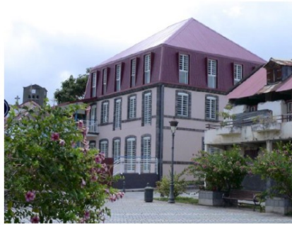
Vue globale de l'école après renforcement – face avant droite
