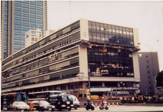
Kobé 1999 Mairie, rupture du 6 ème niveau
