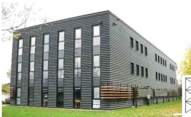
Bâtiment en acier
