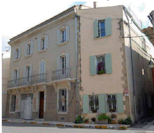
Bâtiment en maçonnerie
