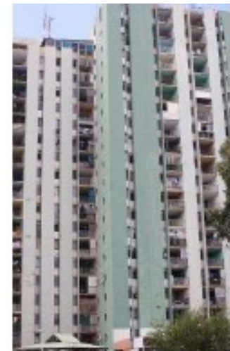
Bâtiment en béton
