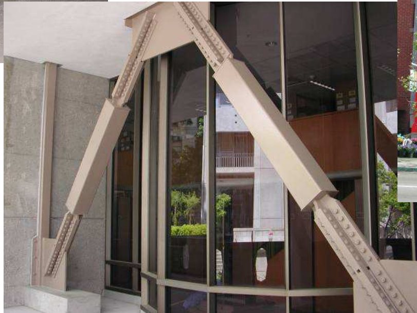
Eléments de stabilité avec amortisseurs
