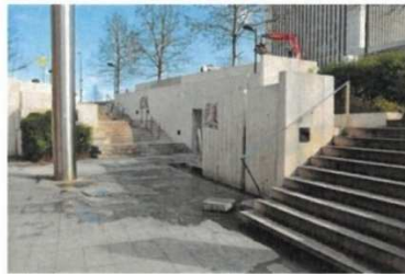
Figure 58 : La place du carrefour Pleyel à Saint-Denis (Arene Ile-de-France, 2011)
