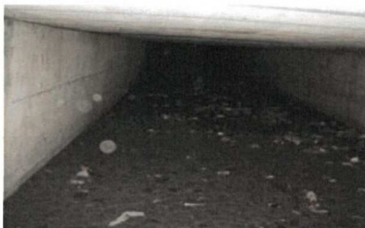
Figure 67 : Bassin enterré – Photo (Communauté Urbaine de Bordeaux, 2014)
