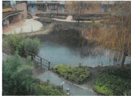
Figure 44 : Marre d'infiltration (Rombaut, 2010)
