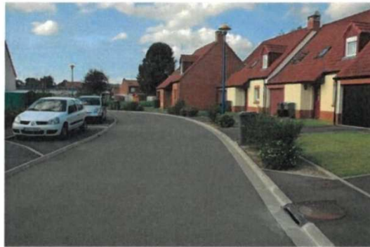
Figure 65 : Chaussée avec enrobés imperméables à structure réservoir – photo : (Lille Métropole Communauté urbaine, 2012)
