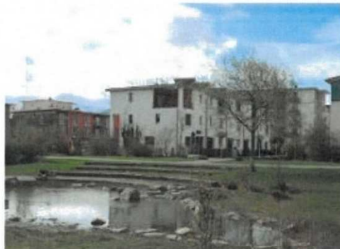
Figure 55 : Bassin de rétention (Ministère de l'Environnement, de l'Energie et de la Mer, 2013)
