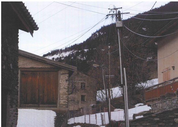
ILLUSTRATION DES CABLES AERIENS TRAVERSANT LE HAMEAU DU VILLARD
