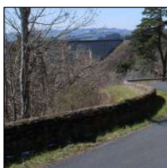
Parapet en pierres
