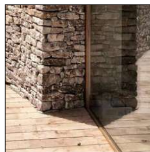
Terrasse bois en continuité du plancher intérieur
