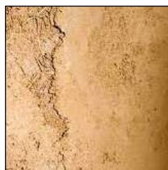
Enduit terre crue et paille de blé
