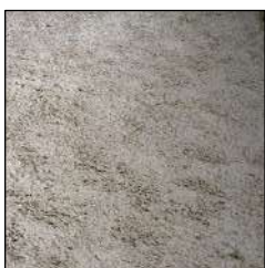
Enduit extérieur chaux chanvre
