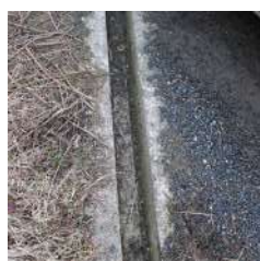
Rigole de gestion de l'eau en bord de voirie
