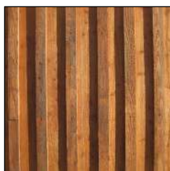
Bardage bois avec couvre joint
