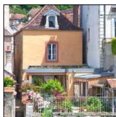
Extension toiture terrasse végétalisée
