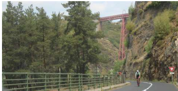
A proximité du Viaduc de Garabit, la voirie est plus large et dispose d'un caractère plus routier. Différents usagers s'y rencontrent.
