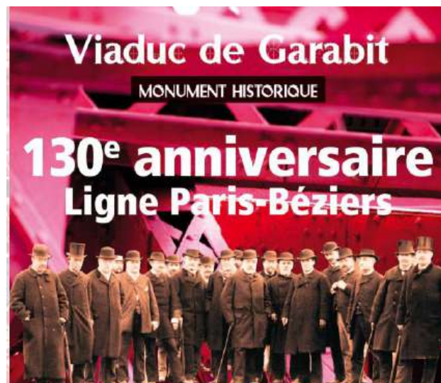
Le viaduc de Garabit est régulièrement mis à l'honneur par l'association les amis du Viaduc de Garabit, comme ici à l'occasion des 130 ans de la ligne ferroviaire.
