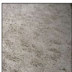
Enduit extérieur chaux chanvre
