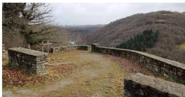
Les belvédères le long de la route présentent des aménagements semblables. Identifiables par leurs murets en pierre, ils permettent de suivre la Truyère et ses paysages.
