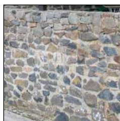
Muret à «joints beurrés»
