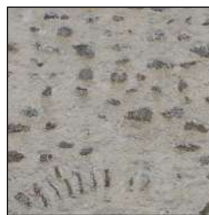
Enduit à « joints beurrés »
