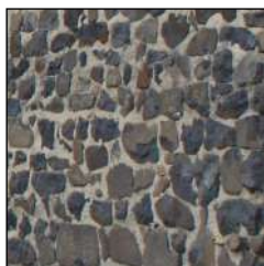
Moellons liés avec joints
