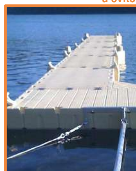
Pontons flottants plastiques
