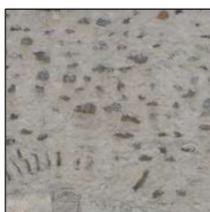
Enduit à joints grossiers réalisé au mortier de chaux
