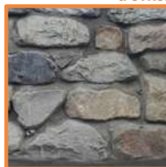
Mur de soutènement en enrochement
