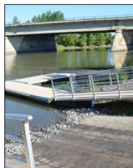
Cale béton en situation de rive de galets Structures métalliques acier inoxydable
