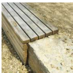
Assise bois sur muret empierré
