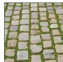
Pavés de pierres locales joints enherbés
