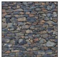
Moellon en pierres sans enduit
