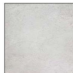
Enduit à la chaux
