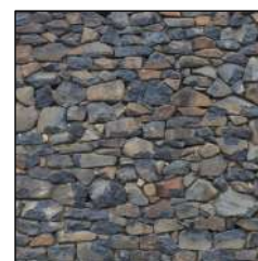
Moellons en pierre sans enduit
