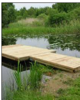
Pontons flottants en platelage bois (essences locales, classe 4)
