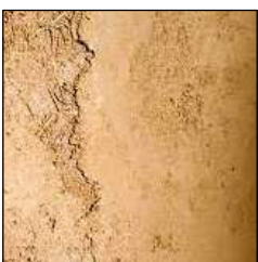
Enduit terre crue et paille de blé
