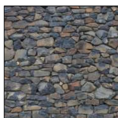
Moellons en pierre sans enduit
