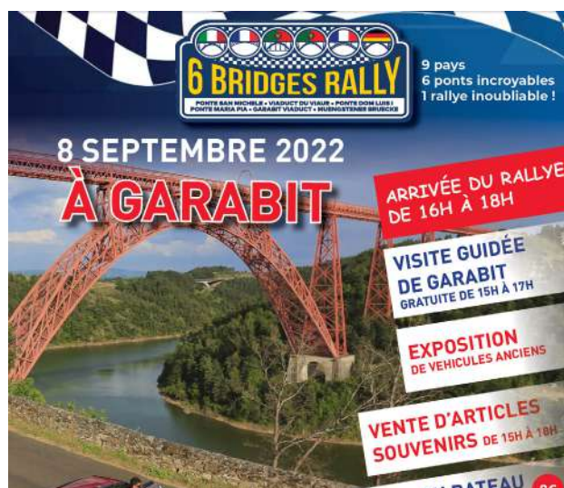
La vallée ennoyée de la Truyère et le viaduc de Garabit offrent un cadre grandiose et préservé. Le site devient attractif pour la tenue d'événement.
