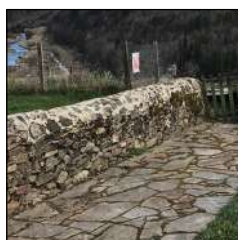
Dallage pierre avec joints enherbés
