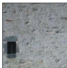
Enduit couvrant réalisé au mortier de chaux
