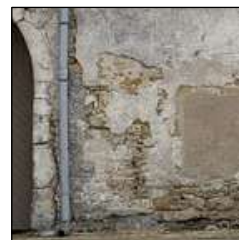
Descentes d'eau en zinc naturel
