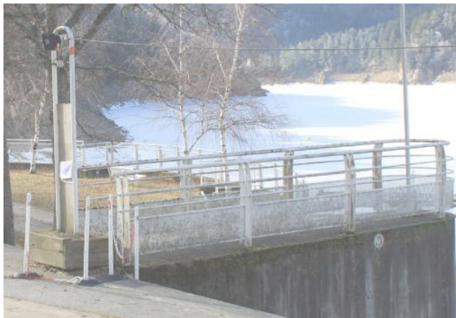
Gardes-corps et mobilier métallique n'entrant pas en dialogue avec le site.
