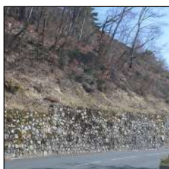
Mur de soutènement en pierre locale
