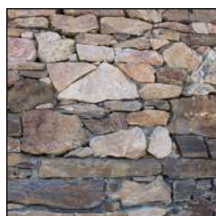
Pierres liées entre elles à l'aide de joints fins
