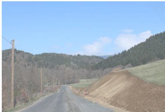
L'élargissement des routes ne doit pas venir détériorer la qualité du site. Les talus doivent être sobrement dimensionnés.
