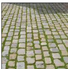
Pavés joints enherbés
