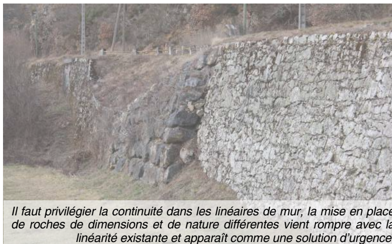
Muret avec jointement béton grossier et rambarde peu qualitative, une couleur moins tranchante est préférable.
