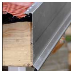
Rive en zinc
