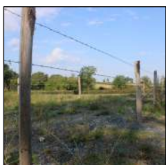
Clôture en piquet bois et fil barbelé ou acier galvanisé
