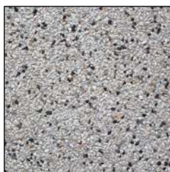
Béton désactivé de teinte claire et naturelle
