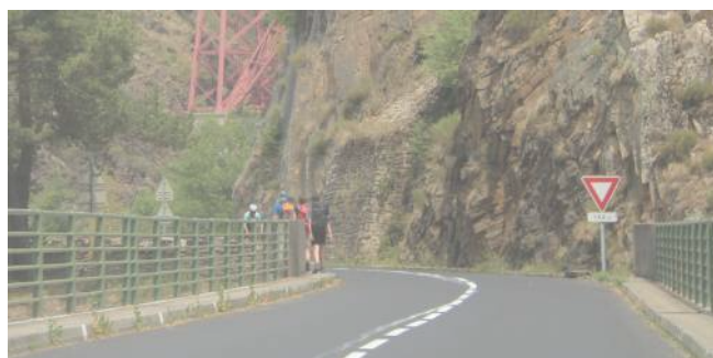
Le passage de parapets en pierre à une glissière métallique apparaît comme brutal. Il est préférable de conserver au sein d'un même champ de vision les mêmes abords.
