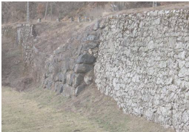
Le changement de traitement du mur de soutènement par enrochement est malvenu et dénature l'ouvrage historique.
