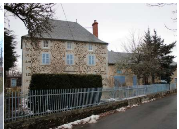
Muret en pierres maçonnées et clôture métallique peinte
