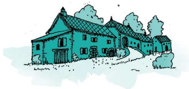
L'habitat en bande dit « barriade » groupe de 5 ou 6 maisons dans des volumes simples couverts de toitures à deux pans, suivant une orientation sud-ouest.
