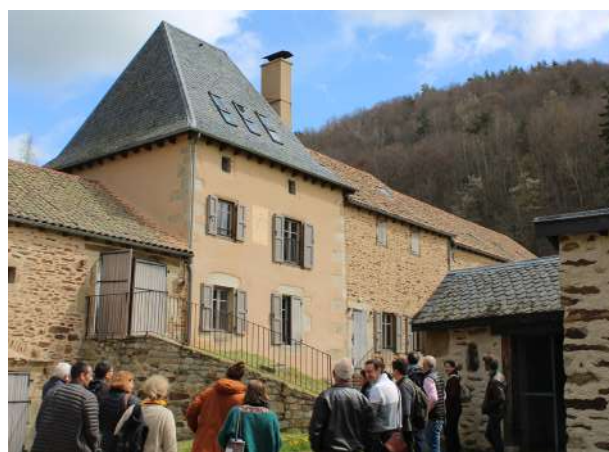
Le Domaine de Laval à Chaliers est un exemple de restauration de qualité, la recherche de matériaux de qualité, menuiseries, ouvertures intelligentes ont permis de moderniser son usage sans dénaturer le bâti.
