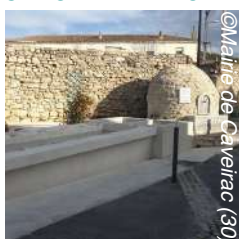
Réhabilitation du lavoir communal selon des procédés d'origine
