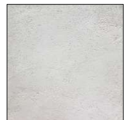
Enduit à la chaux
