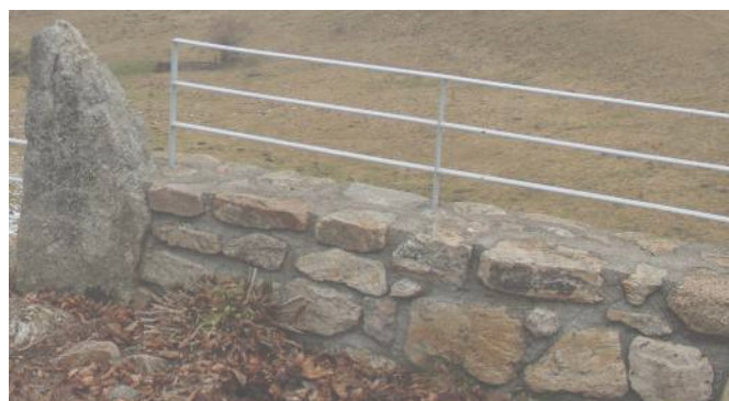
Muret avec jointement béton grossier et rambarde peu qualitative, une couleur moins tranchante est préférable.
