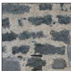
Enduit à pierre vue réalisé au mortier de chaux
