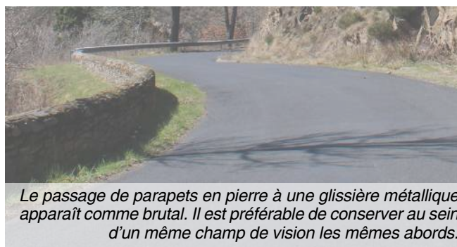
L'élargissement des routes ne doit pas venir détériorer la qualité du site. Les talus doivent être sobrement dimensionnés.
