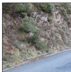
Bordures béton discrètes
