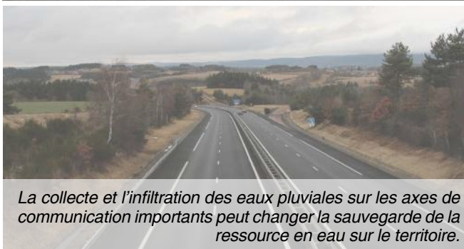
L'enrobé est un revêtement imperméable qui empêche l'infiltration des eaux pluviales et entraîne de forts ruissellements. Il faut l'éviter au maximum, surtout dans les espaces publics ou des solutions alternatives existes (bandes enherbées, noues).
