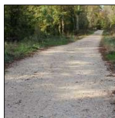
Sol compacté et empierré
