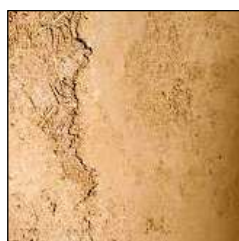
Enduit terre crue et paille de blé
