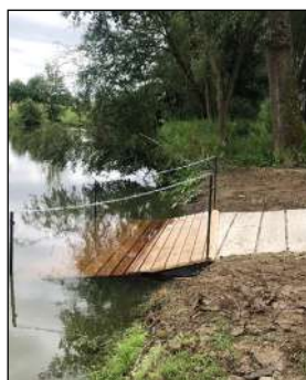
Rampe dallage béton et platelage bois pour petites embarcations
