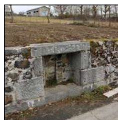
Encadré dans mur en pierre
