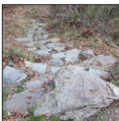
Emmarchements en enrochements existants
