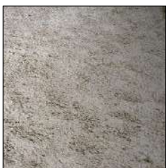
Enduit extérieur chaux chanvre
