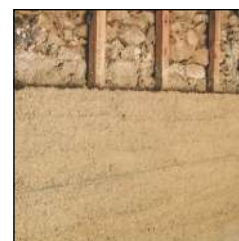
Chaux-chanvre projeté (correcteur thermique)
