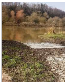
Dallage béton intégré dans une pente légère
