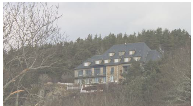
Gardes corps des terrasses et belvédères surplombant la vallée, très visibles depuis les extérieures.
