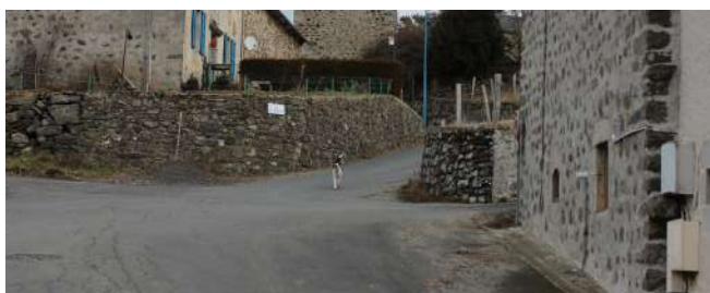
Espace public et rue imperméabilisées. L'usage d'enrobé favorise un ruissellement rapide des eaux pluviales, contraire aux principes de gestion de l'eau.
