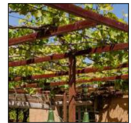
Treille métallique végétalisée
