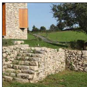
Terrasse appuyée sur muret en pierre traditionnel
