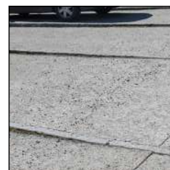
Béton désactivé de granit
