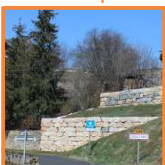
Mur de soutènement grossier
