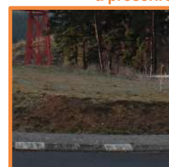
Bordures béton prégnantes
