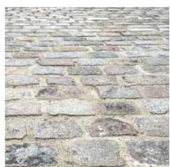
Pavage en pierre locale (granite)
