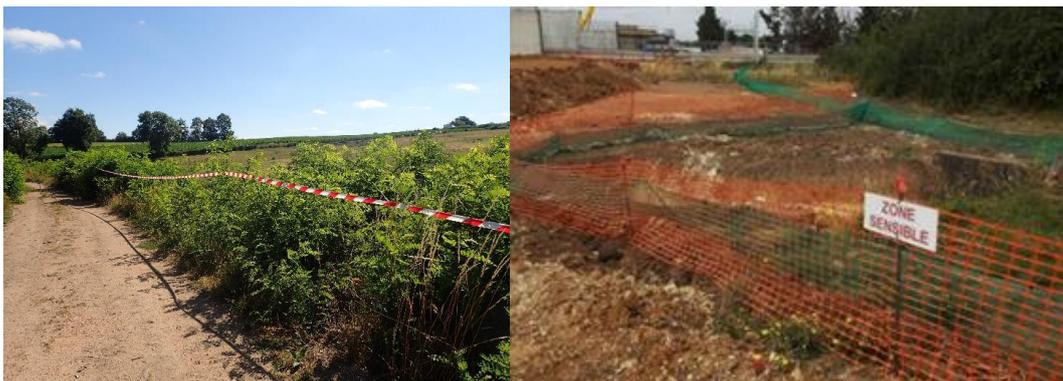
Figure 19. Exemples de balisage de zone sensible en phase travaux (Source Crexeco)
