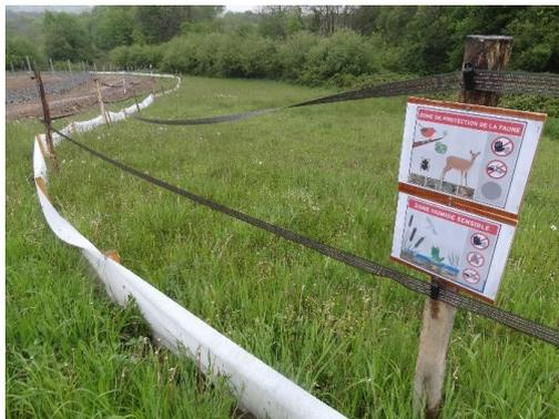
Figure 20. Exemple de clôture anti-pénétration en phase travaux (Source Crexeco)
