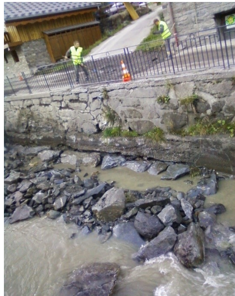
Figure 27 : Vue sur les travaux de reprise en sous œuvre en rive gauche (à gauche : état en 2023 ; à droite : travaux en cours)
