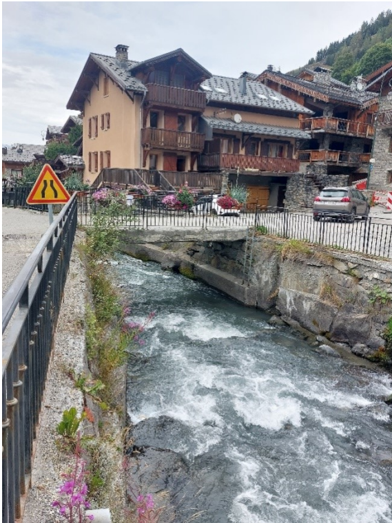
Figure 28 : Vue sur la face amont de l'OH3
