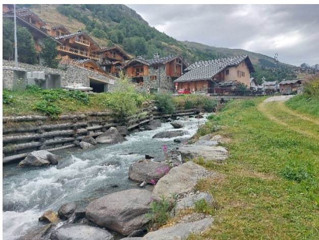
Figure 40 : Vue sur protection de berge rive droite
