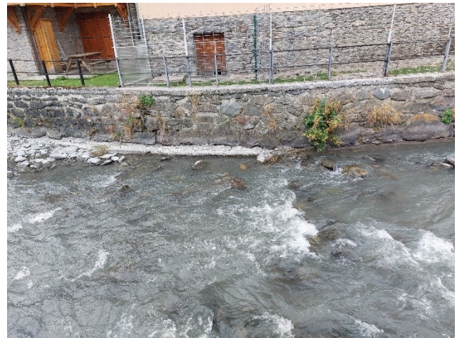
Figure 24 : Vue sur le mur rive droite
