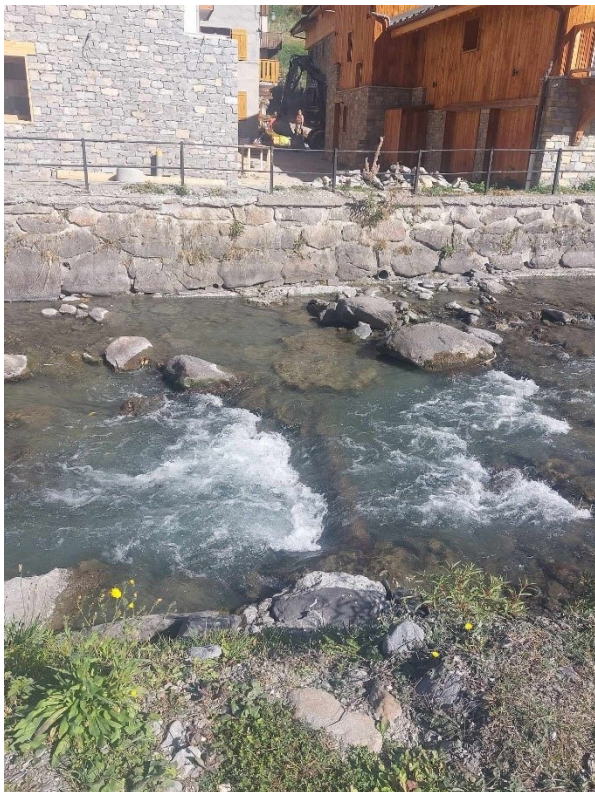
Figure 31 : Vue sur le réseau affleurant
