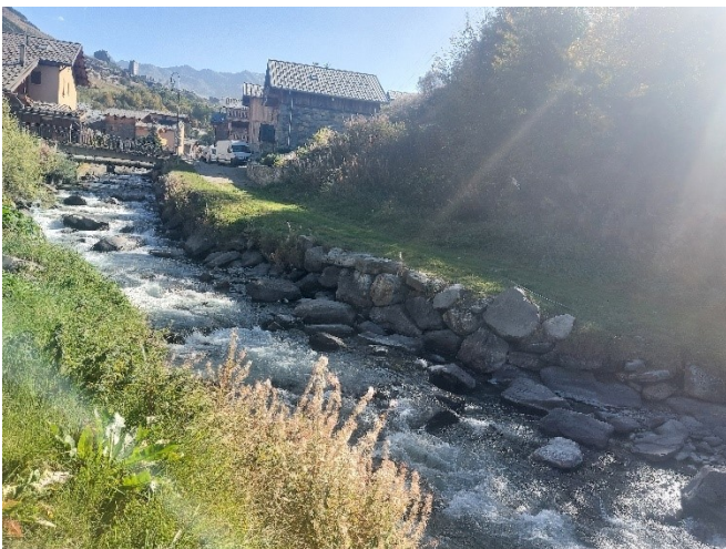
Figure 44 : Vue sur la protection de berge rive gauche le long du chemin (1/2)
