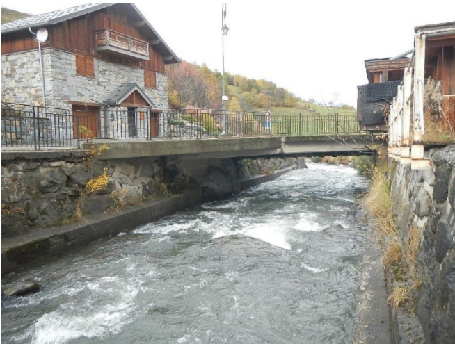
Figure 46 : Vue sur la face amont du pont 4 (1/2)
