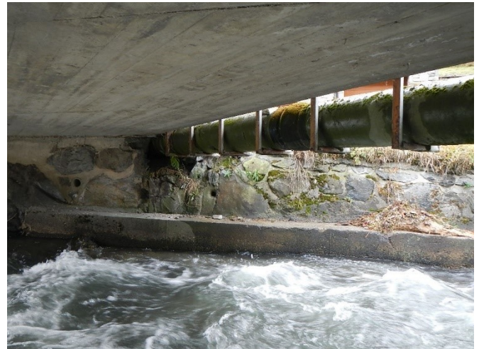
Figure 51 : Vue sur la conduite EU en encorbellement sous le pont 4 (2/2)
