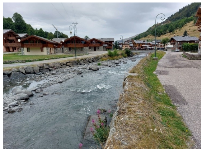
Figure 6 : Vue sur le cours d'eau depuis la digue rive droite
