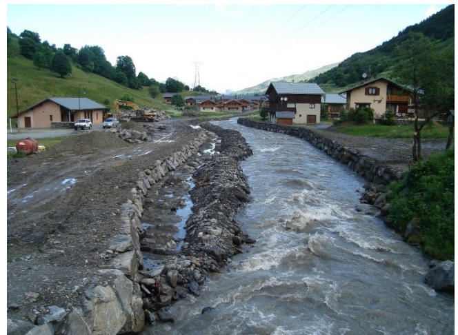
Figure 15 : Photo datant des travaux de 2010 – on visualise le sabot en enrochements bétonnés calé à peu près au niveau de fond du lit
