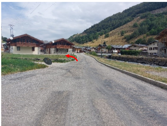
Figure 58 : Zone de premiers débordements en rive gauche (1/2)
