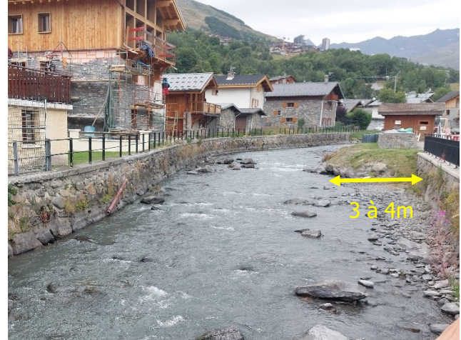
Figure 26 : Vue sur l'extrémité amont du mur et l'avancée de la berge dans le lit
