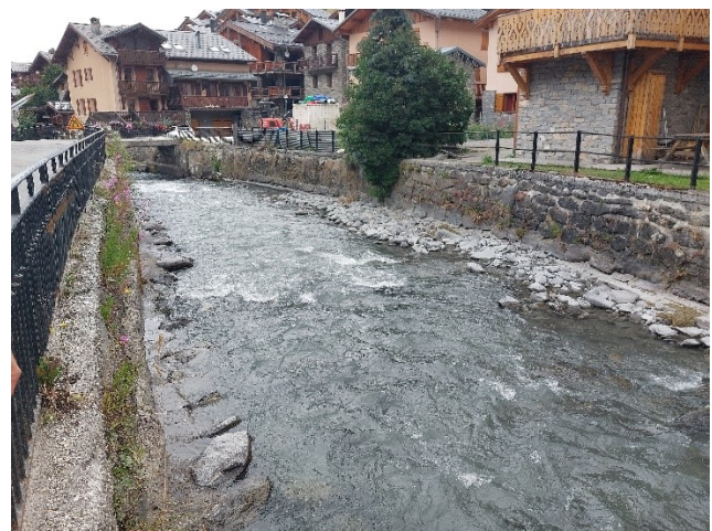
Figure 22 : Tronçon 2 - en approche de l'OH3
