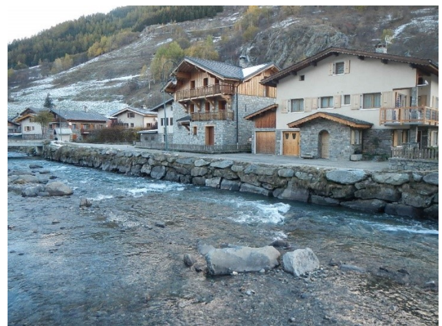
Figure 8 : Vue sur le parement de la digue en enrochements
