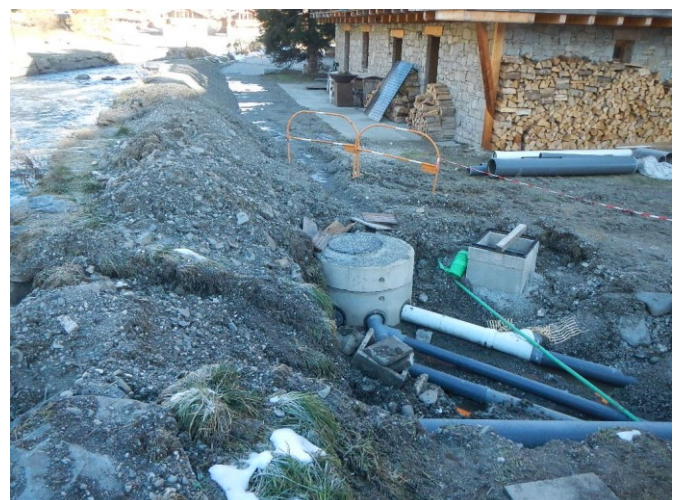
Figure 20 : Vue sur le réseau EU en pied de digue
