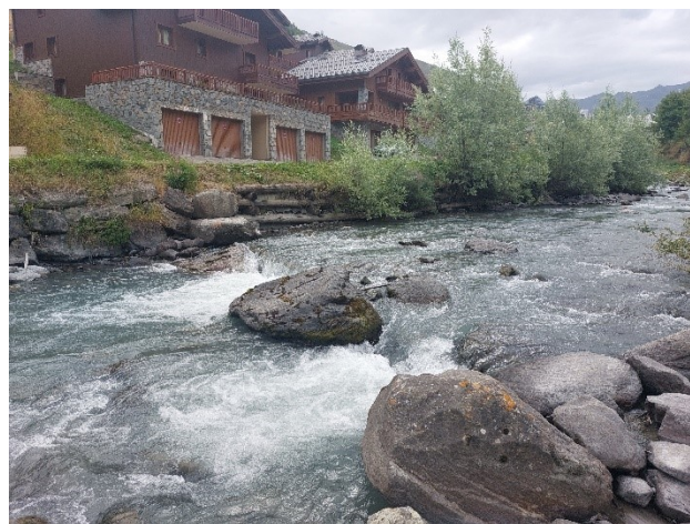
Figure 41 : Vue sur l'extrémité aval de la protection rive droite
