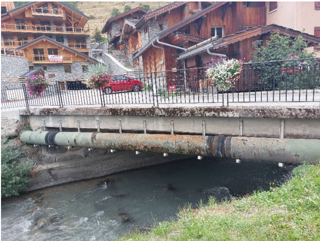
Figure 50 : Vue sur la conduite EU en encorbellement sous le pont 4 (1/2)
