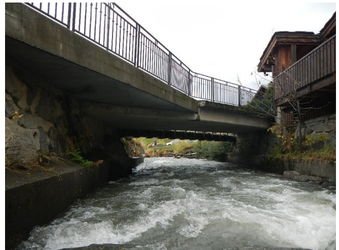
Figure 47 : Vue sur la face amont du pont 4 (2/2)
