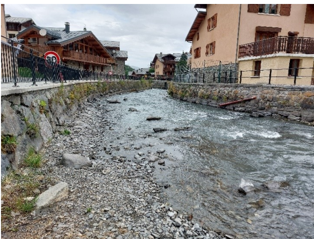
Figure 21 : Vue sur la partie aval du tronçon 2
