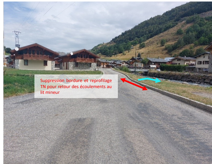
Figure 74 : Aménagement sommet de berge rive gauche
