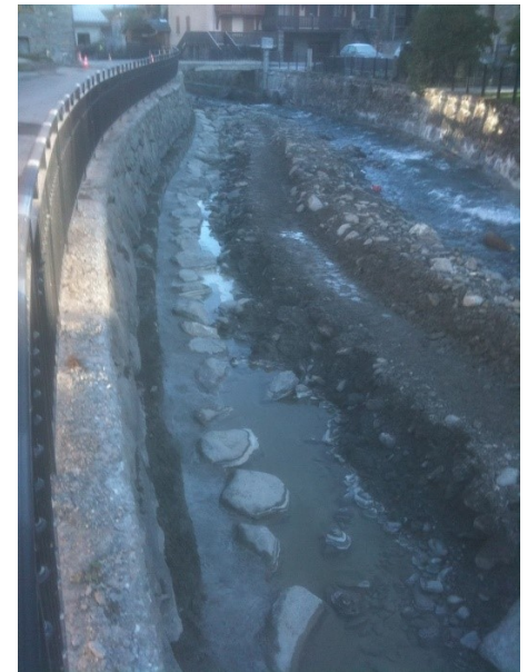
Figure 27 : Vue sur les travaux de reprise en sous œuvre en rive gauche (à gauche : état en 2023 ; à droite : travaux en cours)
