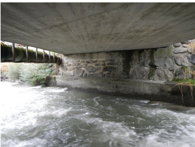
Figure 37 : Vue sur la protection de berge rive droite sous le pont 4
