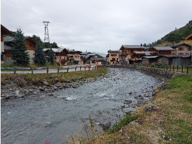
Figure 25 : Vue sur la rive gauche en aval de l'OH2
