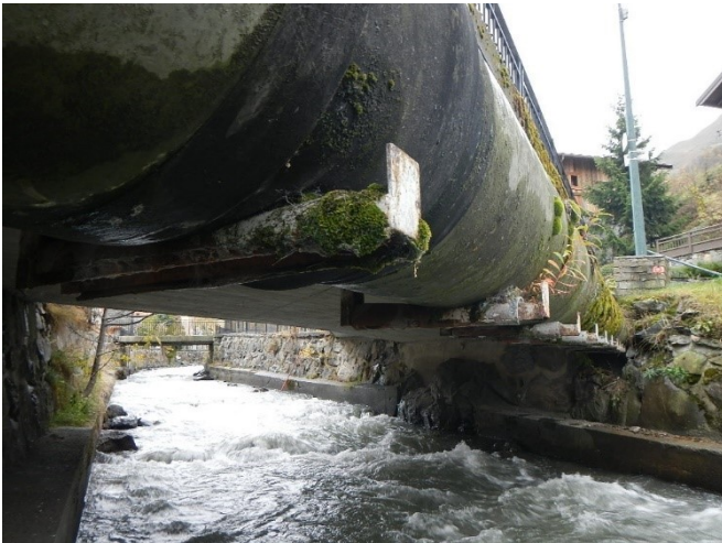
Figure 42 : Vue sur le mur rive gauche sous le pont 4
