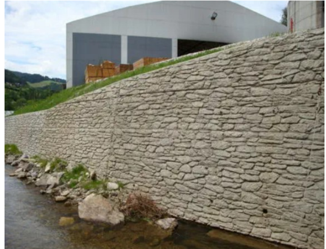
Figure 70 : Exemple béton matricé (source : RECKLI)
