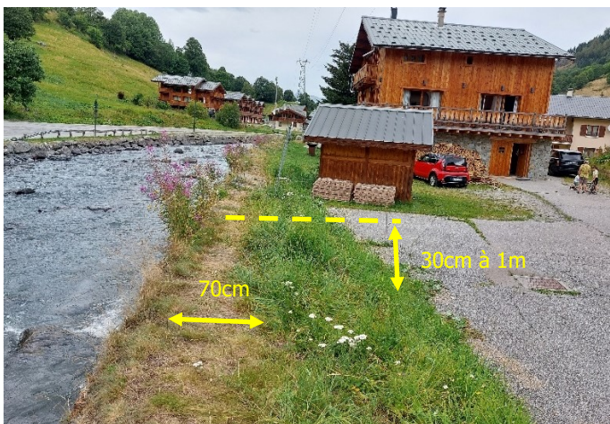
Figure 7 : Vue sur la crête de digue
