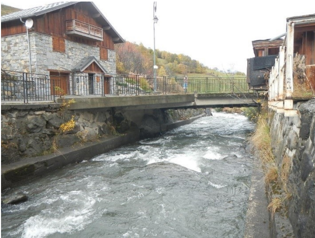
Figure 35 : Vue sur la partie amont du tronçon 3 (amont pont 4)
