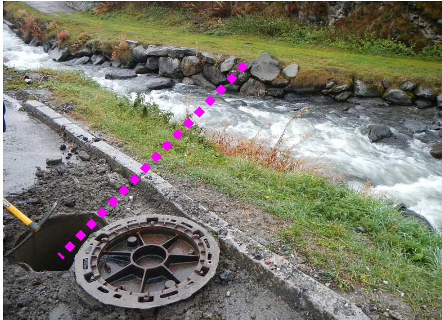
Figure 53 : Vue sur la zone de franchissement
