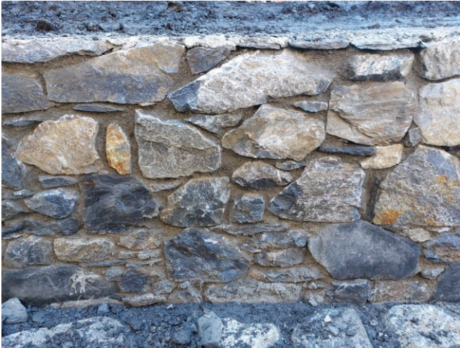
Figure 69 : Exemple habillage mur en pierre de taille
