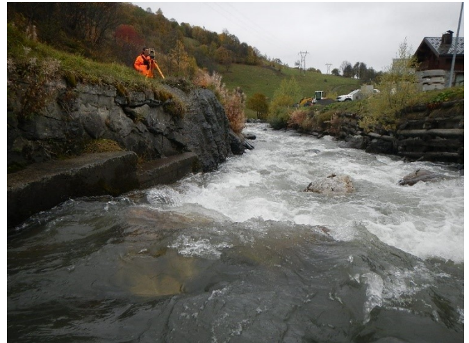
Figure 43 : Vue sur l'extrémité aval de la protection rive gauche (ancrage sur rocher)
