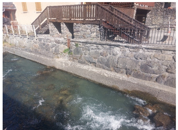
Figure 38 : Vue sur la protection de berge rive droite en amont du pont 4
