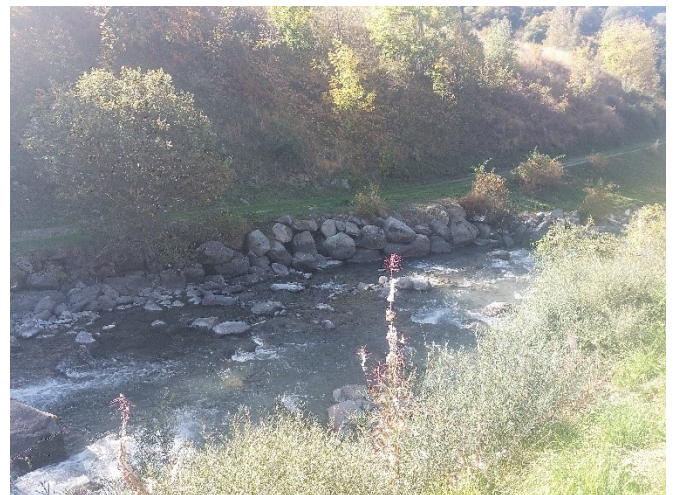
Figure 45 : Vue sur la protection de berge rive gauche le long du chemin (2/2)
