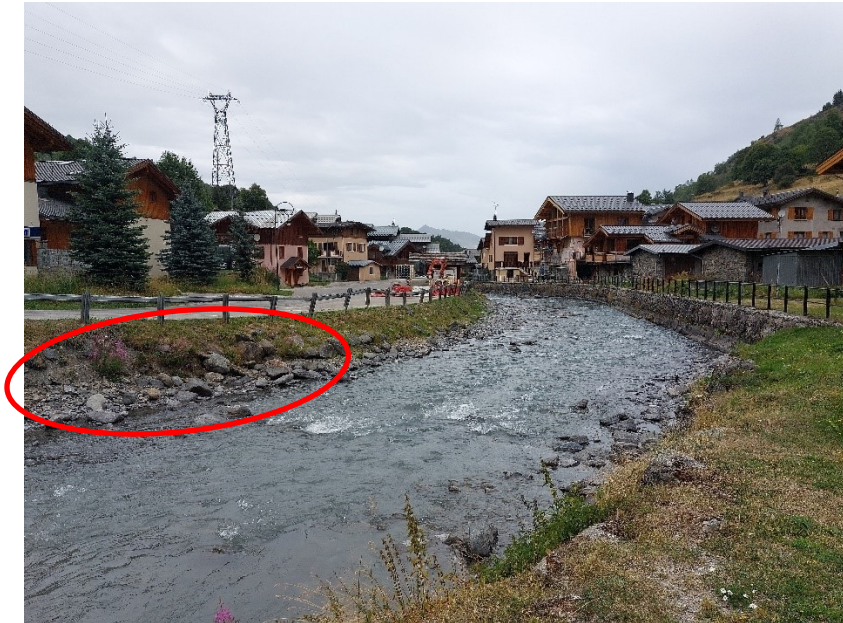
Figure 78 : Traitement de l'érosion rive gauche en aval du pont 2
