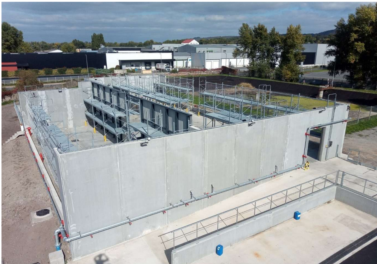
Plateforme de stockage conteneurs inflammables
