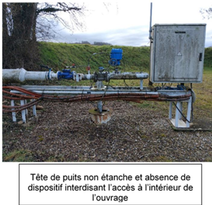
Non-conformités constatées sur les forages d'eau
