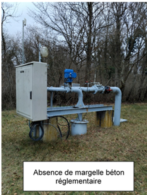
Non-conformités constatées sur les forages d'eau
