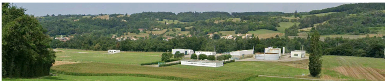
Vue sur la concession du Châtelard (depuis un point de vue haut dégagé du versant sud) – source : google earth 2026
