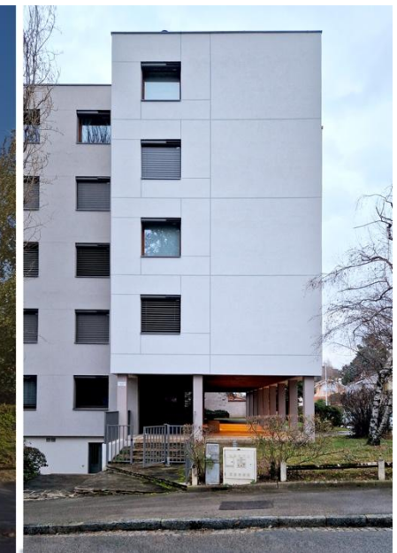
27 Balme – Lyon 03 Rénovation énergétique de 18 logements
