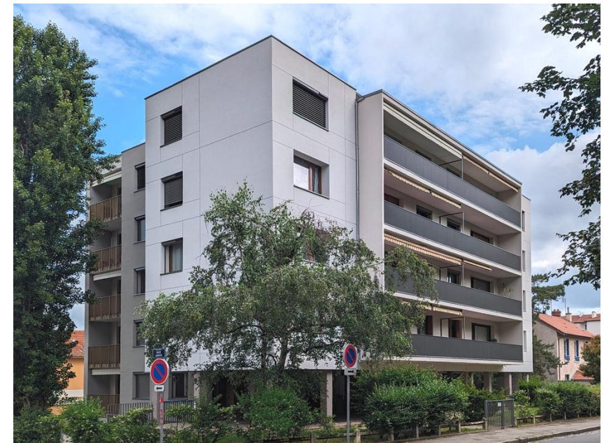
27 Balme – Lyon 03 Rénovation énergétique de 18 logements
