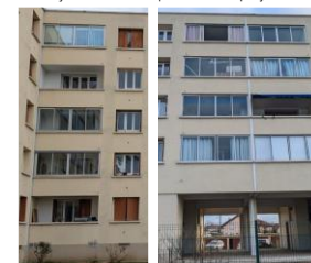
Façade Sud-Ouest – Loggias fermées ou ouvertes, présence ponctuelle de stores bannes, rideaux ou stores intérieurs
