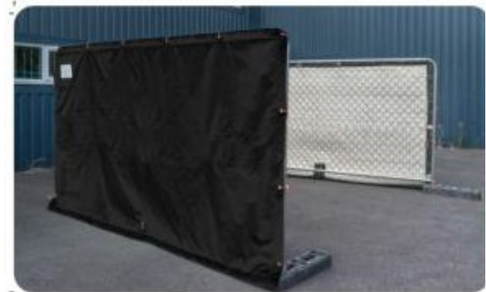
Bâches acoustiques mises en place
