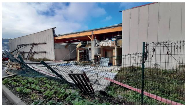
Dégradation du mur d'un local commercial suite à des fortes intempéries de vent (16 décembre 2024)
