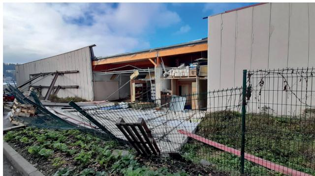
Dégradation du mur d'un local commercial suite à des fortes intempéries de vent (16 décembre 2024)
