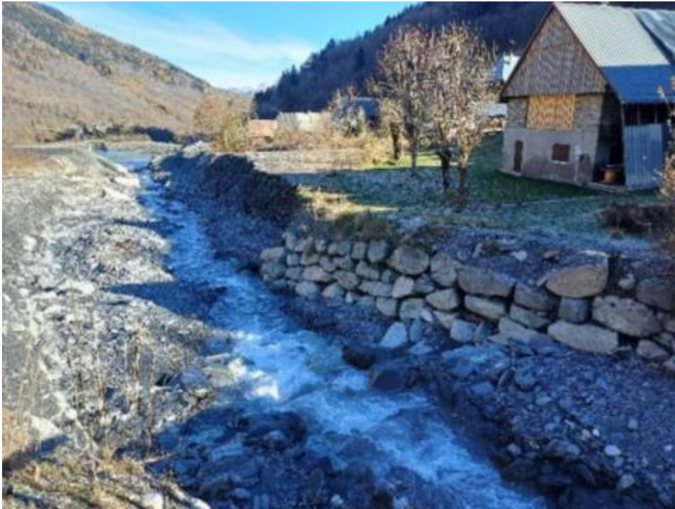
Figure 6: Protection existante en rive droite à l'aval immédiat du pont communal
