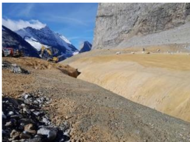
Photo 48 : Régalinge des zones de dépôts des matériaux de déblais du chenal – source RTM, 2023
