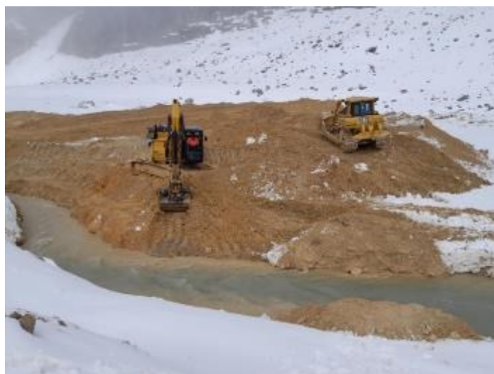
Photo 10: Terrassement des matériaux de déblais du creusement du chenal en rive droite (source RTM, 2023)
