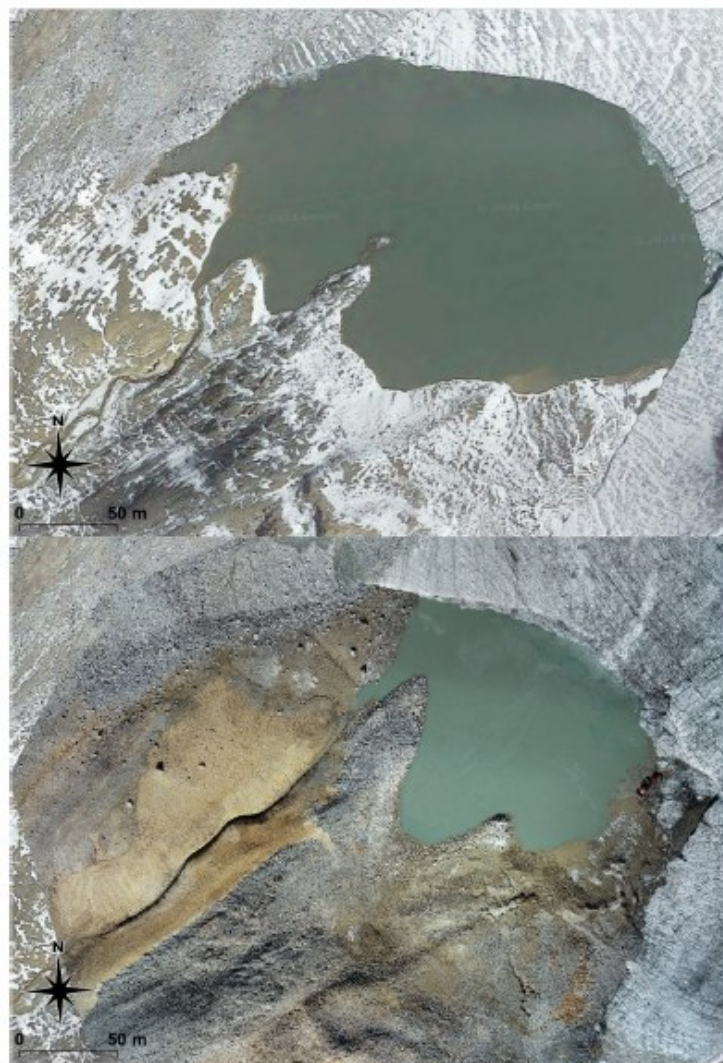
Figure 2: Comparaison du lac de Rosolin en septembre 2022 (en haut image Landsat/Copernicus) avant les travaux et en octobre 2023 après les travaux (en bas image LatitudeDrone)
