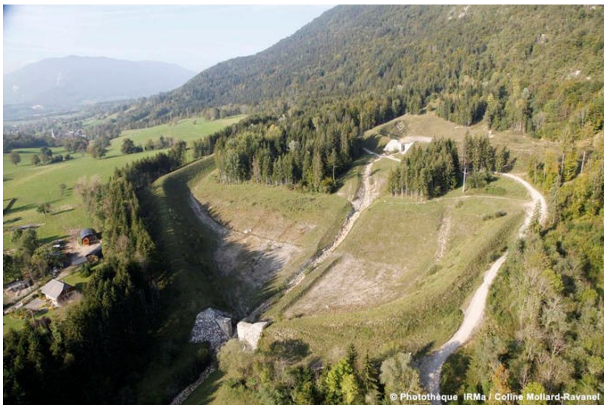
Figure 4 : exemple d'une succession de plages de dépôts réalisées au Chatelard (forêt domaniale R.T.M du Nant des Granges). La capacité de ce système est de l'ordre de 100 000 m 3 . Notez la dimension de l'ouvrage par rapport aux bâtiments présents sur la photo.
