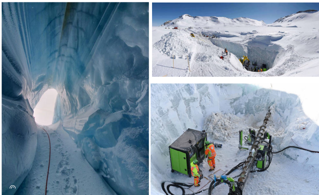
Figure 14 : vue d'une galerie sous glaciaire creusée par l'eau de vidange du lac de Plaine Morte. On peut apercevoir, au plafond de la galerie, le micro-tunnel initial réalisé par une foreuse en 2019. [Source photos : https://www.geotest.ch/ ]
