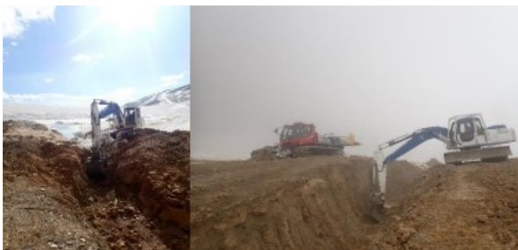
Photo 5, Photo 6: Creusement du chenal (source RTM, 2023)
