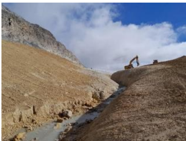
Photo 49 : Régalinge des zones de dépôts des matériaux de déblais du chenal – source RTM, 2023
