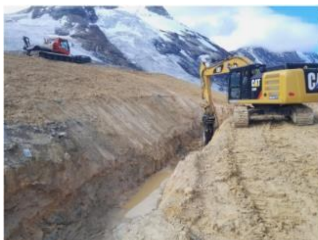
Photo 52 : Sommet de talus du chenal à l'exutoire écrêté – source RTM, 2023
