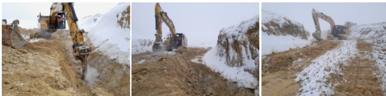
Photo 7, Photo 8, Photo 9: Creusement du chenal phase 2 et de la risberge (source RTM, 2023)
