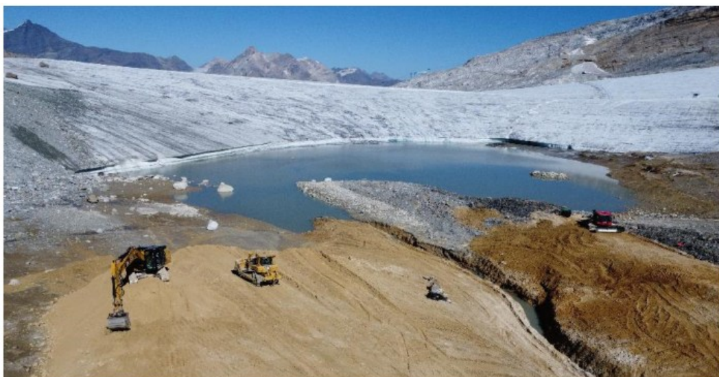
Photo 1: Lac du Rosolin en fin de travaux (RTM, 2023)
