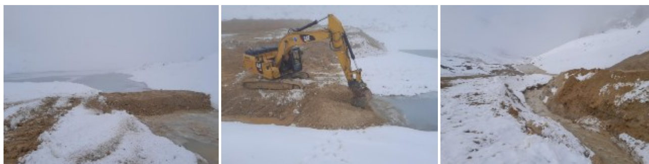
Photo 11, Photo 12, Photo 13: Bouchon en place à l'exutoire du lac, ouverture du bouchon, vidange en cours (source RTM)
