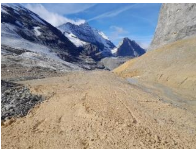
Photo 51 : Bac de décantation en fin de chantier – source RTM, 2023
