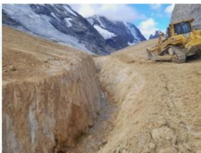
Photo 53 : Sommet de talus du chenal à l'exutoire laissé en l'état (berges rocheuses) – source RTM, 2023
