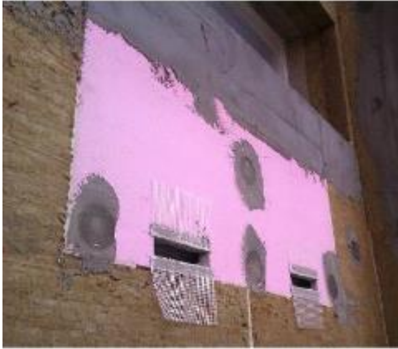
Exemple de gîtes artificiel intégré à une construction
