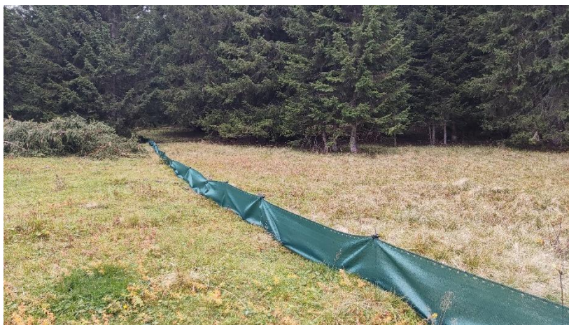
Barrières à amphibiens installés dans le cadre d'un chantier d'aménagement
