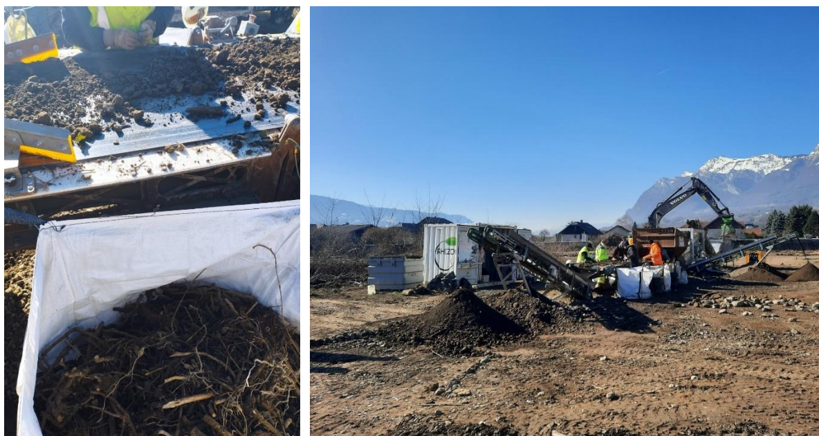
Exemple de chantier de l'entreprise Rhizomex en Isère
