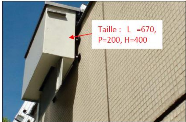
Exemple de gîtes artificiel extérieur installé sur un bâtiment
