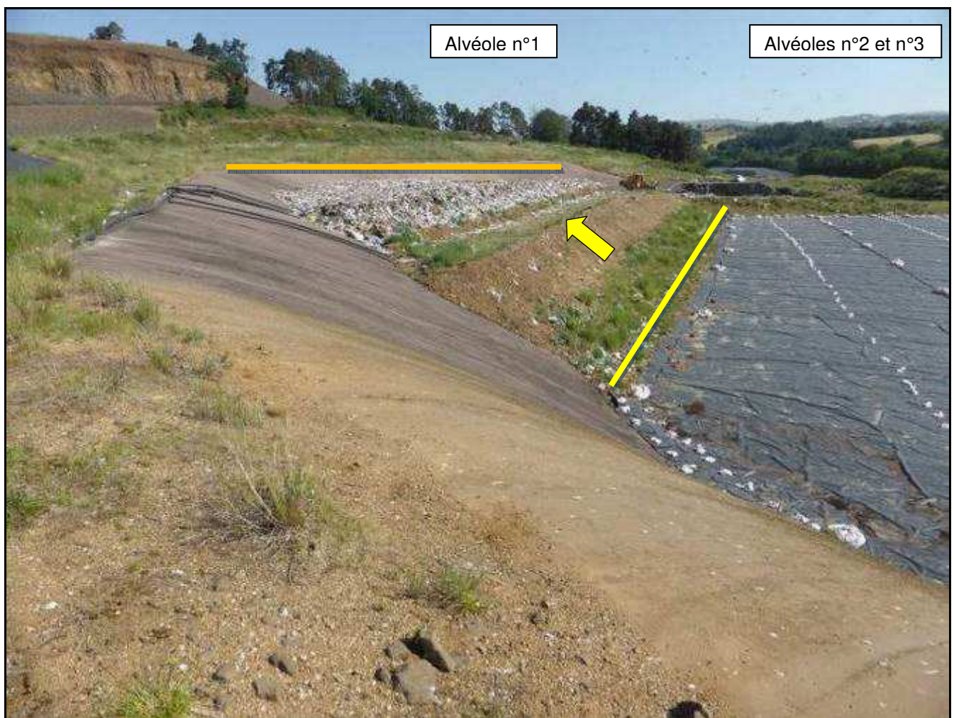
Figure 2 : Configuration géométrique du casier 2
