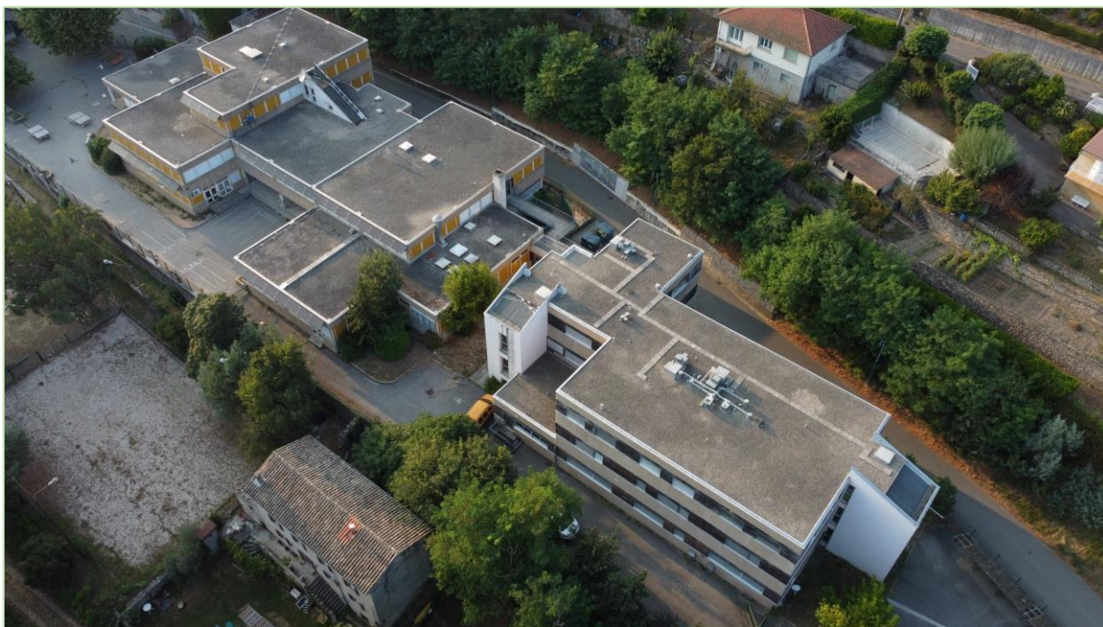
Vue des bâtiments (1 et 2) en drone
