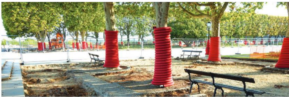
FIGURE 18 : EXEMPLE DE PROTECTION DES ARBRES EN PHASE CHANTIER (SOURCE : VILLE DE MONTPELLIER)
