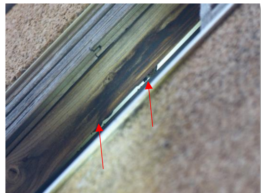
Vue d'un espace occupé, ici entre le volet et le support de bardage, par deux pipistrelles indéterminées (bâtiment 2 côté nord)
