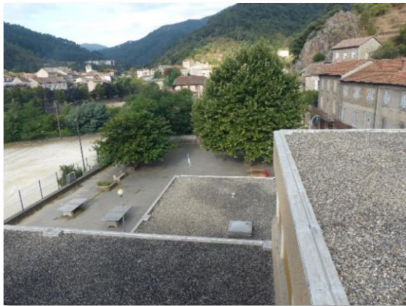
Sur les toits-terrasses, les couvertines en toile goudronnées sont jointives avec les acrotères
