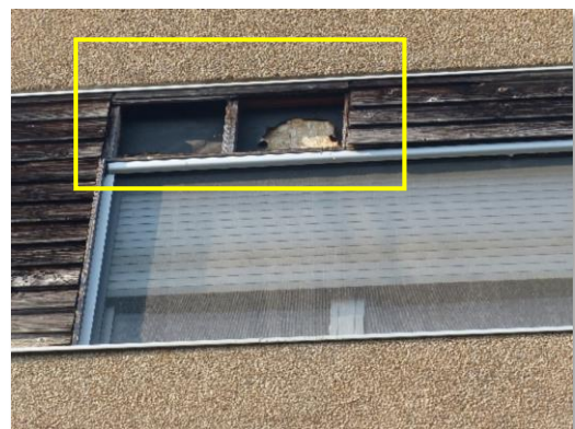
Vue des espaces et de la structure des cloisonnements verticaux à l'arrière des bardages sur une zone où les planches font défaut
