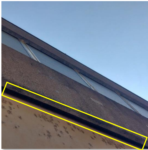
Sur certaines façades du bâtiment 1, on retrouve des espaces larges à l'arrière de ces panneaux...
