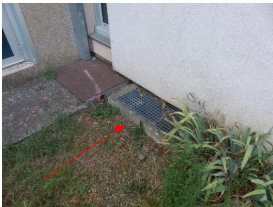
Grille d'aération du vide sanitaire sous le bâtiment de l'internat ne permettant pas d'accès aux chiroptères
