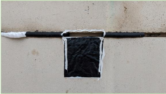
Étapes de mise en œuvre d'un système anti-retour on l'on voit les obturations latérales (mousse PU puis manchon à proximité du SAR) puis la fixation de la bâche plastique à la colle Sika (source Natura scop).
