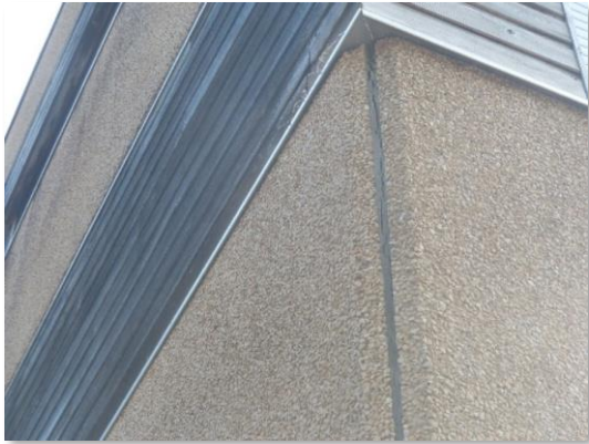
Au niveau des arêtes des bâtiments (ici le bâtiment 2), des joints silicone font l'étanchéité entre les éléments...
