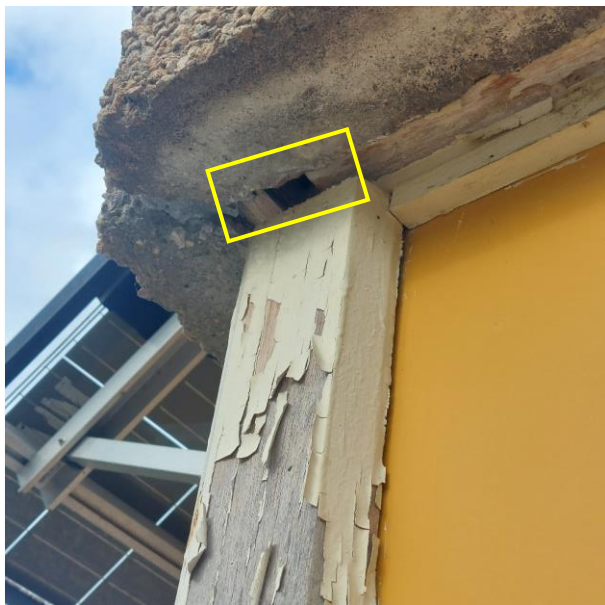
Cumul d'un espace volet roulant/bardage et « corniche » d'un panneau béton
