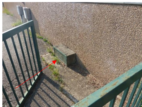
Grille d'aération du vide sanitaire sous le bâtiment de l'internat ne permettant pas d'accès aux chiroptères
