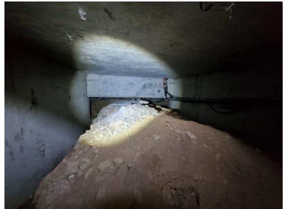
Vue du vide-sanitaire du bâtiment 1
