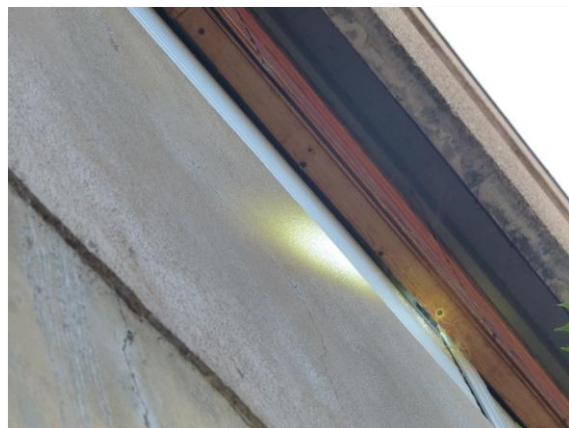
Cumul d'un espace volet roulant/bardage et « corniche » d'un panneau béton
