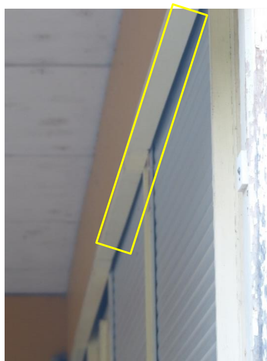
Cumul d'un espace volet roulant/bardage et « corniche » d'un panneau béton
