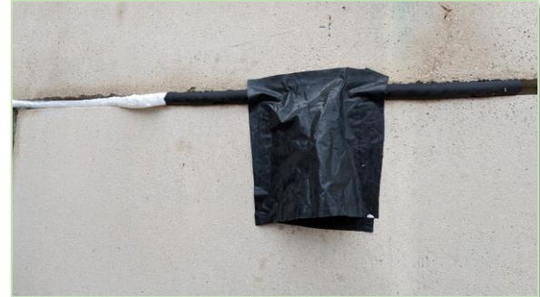
Étapes de mise en œuvre d'un système anti-retour on l'on voit les obturations latérales (mousse PU puis manchon à proximité du SAR) puis la fixation de la bâche plastique à la colle Sika (source Natura scop).
