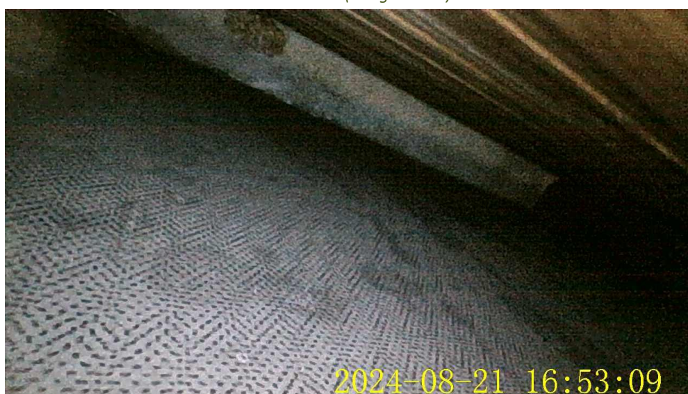
Vue de l'intérieur des espaces à l'arrière du bardage à l'endoscope
