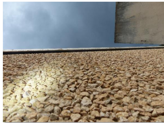
Des couvertines en tôle alu sont aussi présentes, mais bien jointives avec le bâtiment sans laisser d'espaces utilisables
