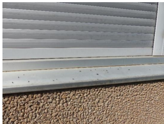
Grains du guano sur une tablette d'hubriserie à l'aplomb d'un espace utilisé
