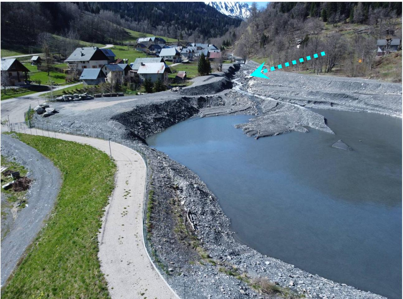
**Photo 19** : Vue des dépôts en queue de retenue.
