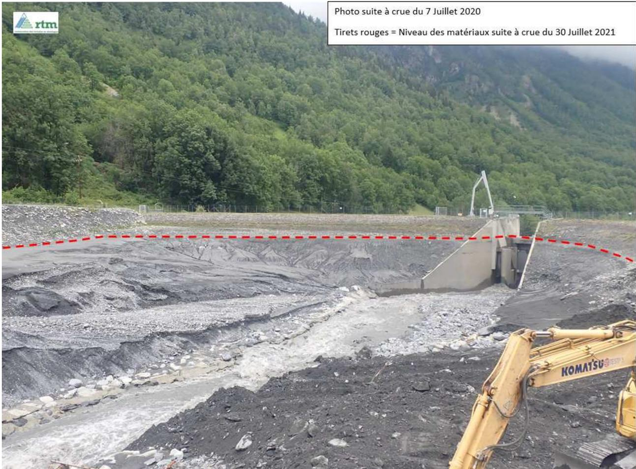
**Figure 4** : Remplissage de la retenue par les matériaux en 2021.
