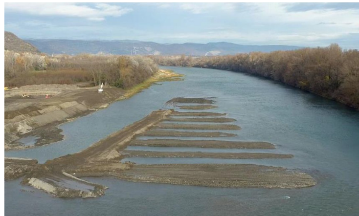
Chantier CNR de restauration des marges alluviales et de remise au cours d'eau de sédiments sur la chute de Pierre Bénite
