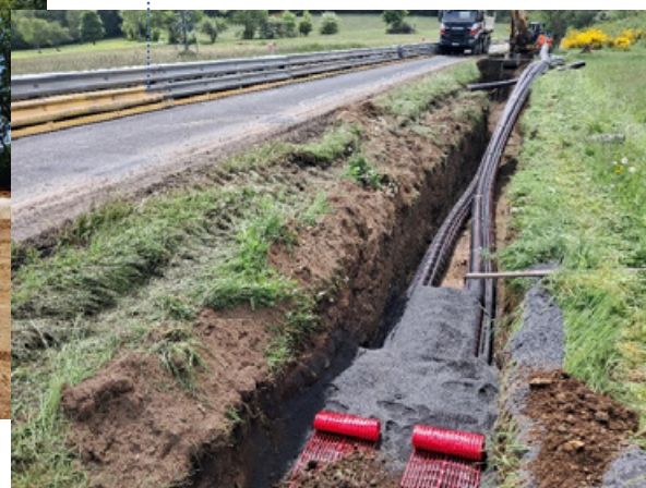
Travaux de construction de la liaison souterraine
