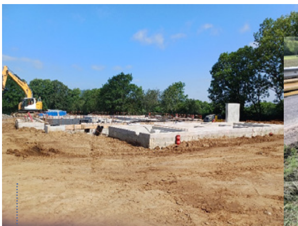
Travaux de construction du poste électrique
