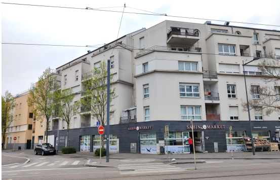
2 - Façade Nord-Nord Ouest
