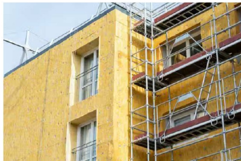
Isolation thermique extérieure d'un bâtiment en copropriété. Lena Constantin/Shutterstock
