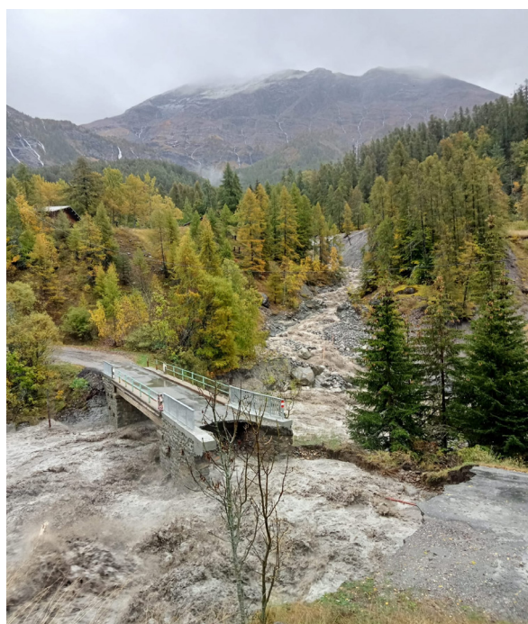
Dégâts suite au débordement du vallon d'Orcières (05) le 20 octobre 2023 (source : Twitter @La_meteo_du_13, carte extraite de l'article de Météo-Paris du 20/10/2023 " Bilan des intempéries de ce 20 octobre 2023 dans le Sud-Est. ")
