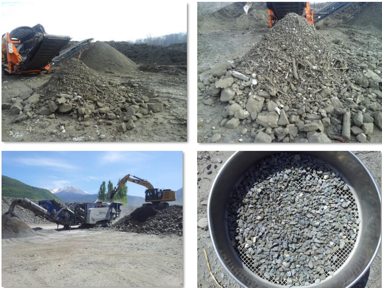
Figure 57 : Exemple de gestion des matériaux contenant des rhizomes de renouée du japon par criblage (photos du haut, Baix, 2020), puis broyage/concassage du refus de criblage (photos du bas, Romanche, 2015). Source : AVP CNR, 2021.
