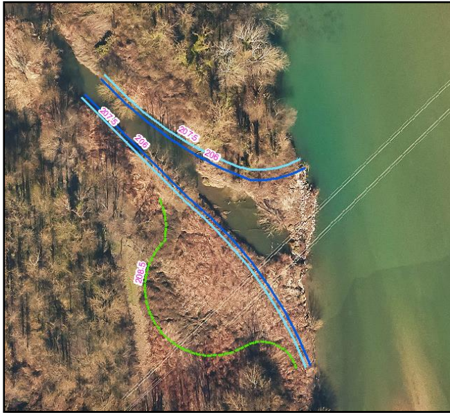
Figure 6 : Emprise de l'ouverture en rive gauche pour l'opération de terrassement du dépôt sédimentaire. En bleu foncé, le fond de la lône ; en bleu clair, la ligne d'eau au débit réservé ; en pointillés verts, la cote de berge du nouvel entonnement.
