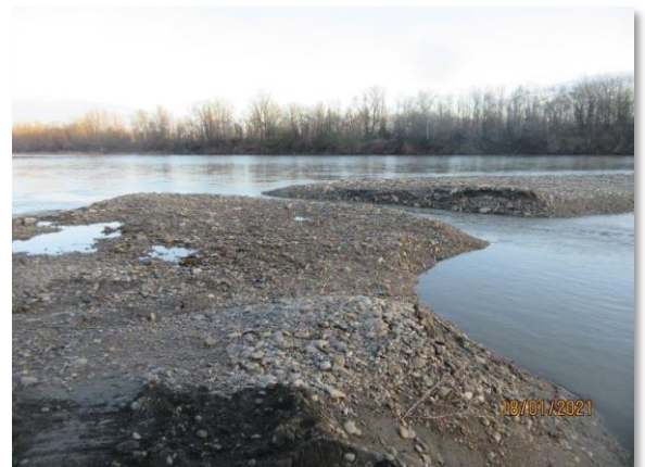
Figure 10 : Exemple de travaux de réinjection de matériaux fins (à gauche) et de matériaux graveleux (à droite) sur le Vieux-Rhône de Baix en 2020-2021. Source CNR, 2021.
