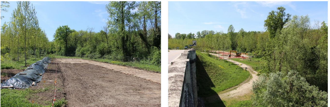
Figure 61 : Base vie et zone de stockage. Source D. Roux-Michollet (SHR), avril 2022.
