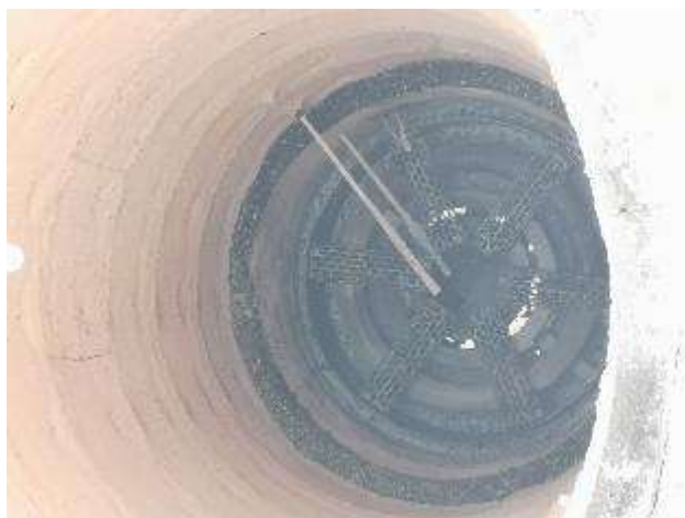
Contrôle de la réhausse Transvap'O et du fût – Bon état
