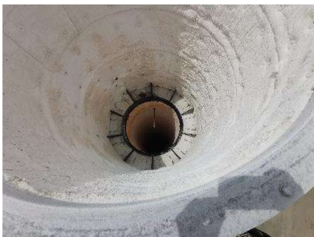
Contrôle de la réhausse Transvap'O et du fût – Bon état
