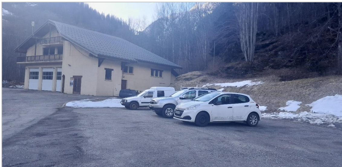
Bâtiments sur la zone d'étude (Karum, 30/01/2024)
