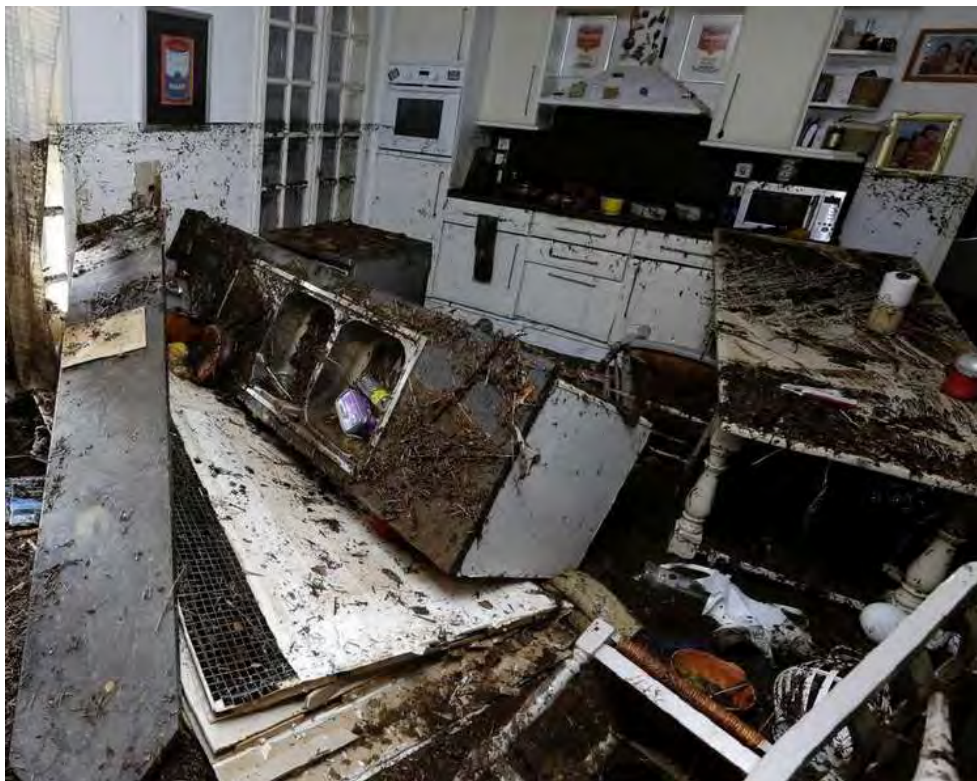
Dégâts à l'intérieur de la maison de plain-pied
