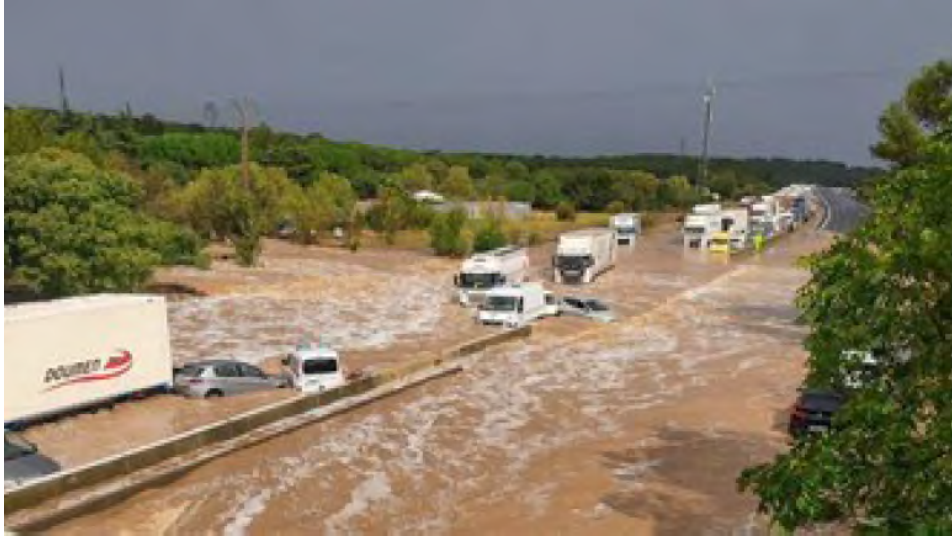
Photos de certains des dégâts causés par le ruissellement et débordement de petits valats au droit de l'A9 entre Langlade et Bernis (photo extraite du rapport Crue du 14 septembre 2021 Vistre - REX descriptif du SPCGD du 12/10/2021)
