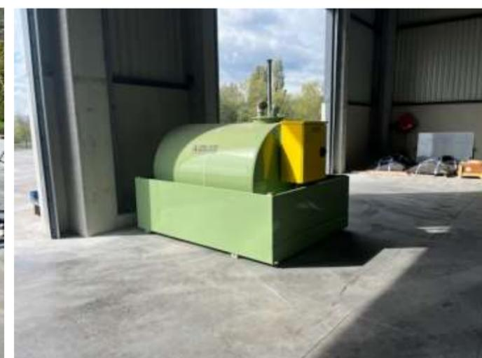
Plateforme SOLUWASTE : Stockage de 3000 l d'hydrocarbures et pompe de distribution sur cuvette de rétention elle-même sur dalle étanche, dans la partie fermée du bâtiment (cliché TS 09/22)
