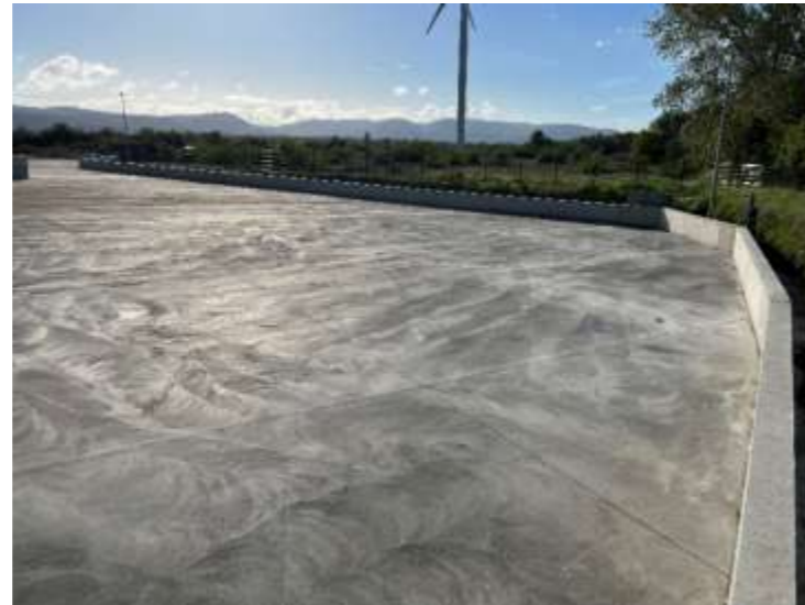
Plateforme SOLUWASTE : angle sud-ouest de l'aire bétonnée, muret béton délimitant l'aire de rétention des eaux pluviales et des eaux d'extinction incendie. Un joint expansif assure l'étanchéité entre le mur et la surface bétonnée (cliché TS 09/22)
