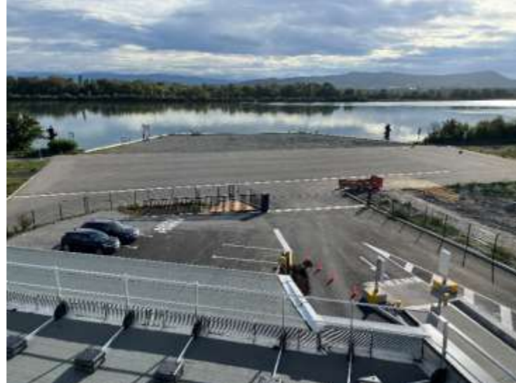
Entrée de la plateforme SOLUWASTE, de la rue du port et du quai fluvial vus depuis le toit du bâtiment (cliché TS 09/22)
