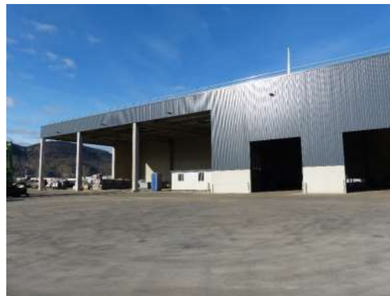
Plateforme SOLUWASTE : façade sud du bâtiment fermé et du hangar semi-ouvert (cliché IATE 01/23)
