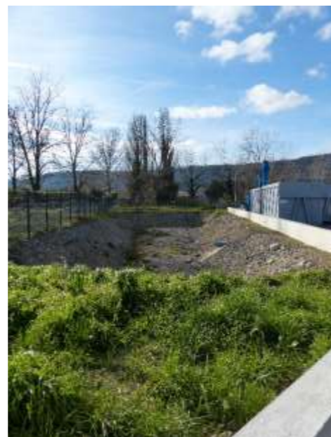
Plateforme SOLUWASTE : bassin de rétention/infiltration des eaux pluviales en cours de végétalisation (cliché IATE 01/23)
