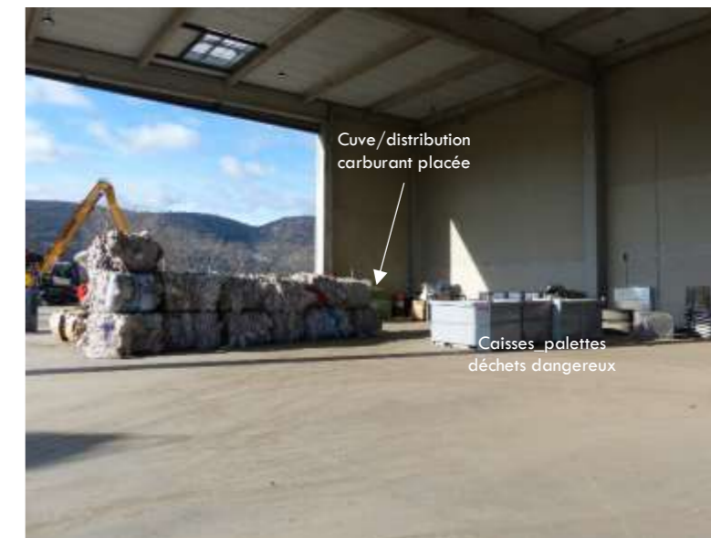
Plateforme SOLUWASTE : stockage des batteries en caisses palettes (cliché IATE 01/23)
