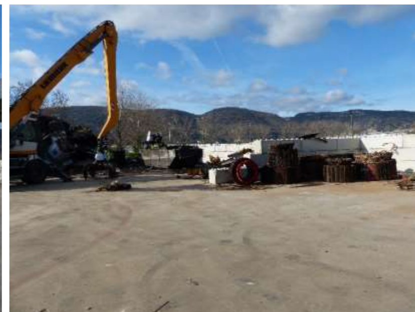
Plateforme SOLUWASTE : vue sur la zone de stockage des ferrailles à chalumer et poste de chalumage/stockage de ferrailles lourdes (cliché IATE 01/23)
