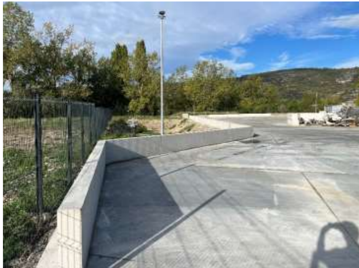
Plateforme SOLUWASTE : angle sud-ouest de l'aire bétonnée, bassin de rétention/infiltration, vanne de fermeture en entrée du bassin et muret béton délimitant l'aire de rétention des eaux pluviales et des eaux d'extinction incendie (cliché TS 09/22)
