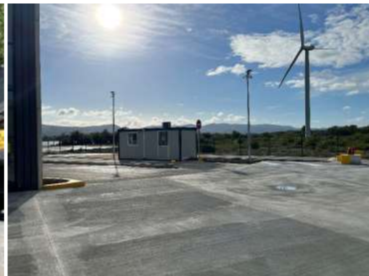
Plateforme SOLUWASTE : la plateforme est totalement clôturée et équipée de mâts avec dispositif de vidéosurveillance en permanence (cliché TS 09/22)
