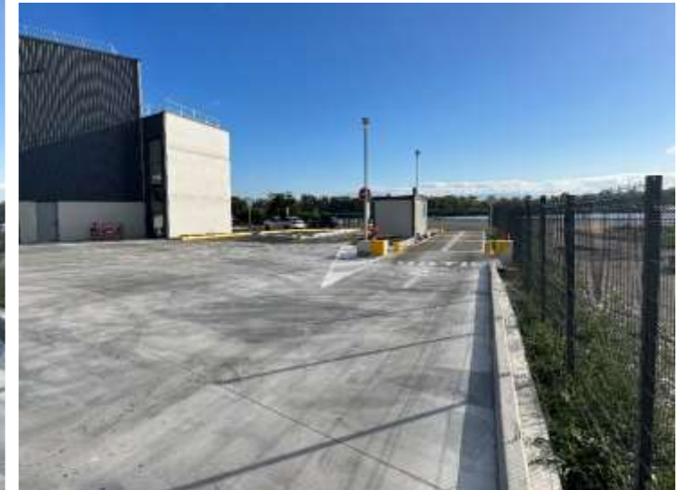
Plateforme SOLUWASTE : ponts bascule entrée et sortie vus depuis l'aire bétonnée de stockage des déchets vers l'entrée du site (cliché TS 09/22)
