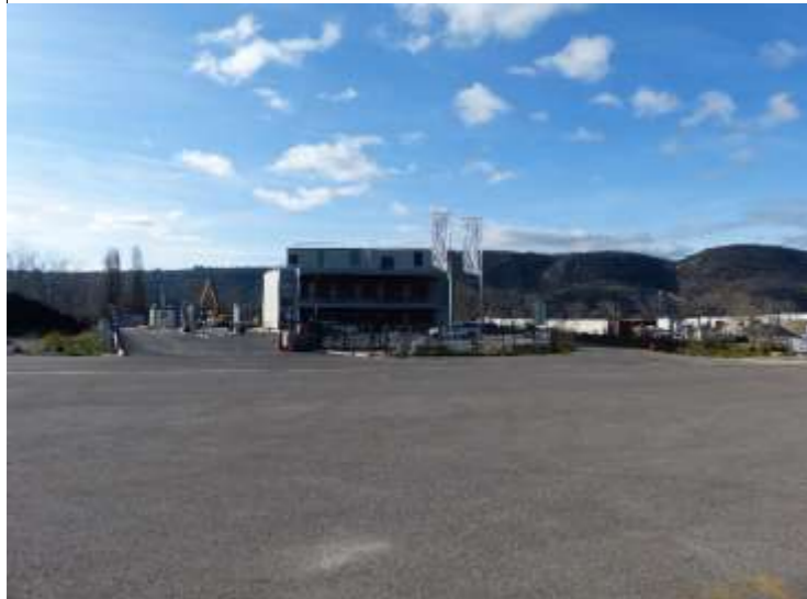
Entrée de la plateforme SOLUWASTE et de la rue du port vues depuis le quai fluvial sur la façade bureaux (cliché TS 01/23)
