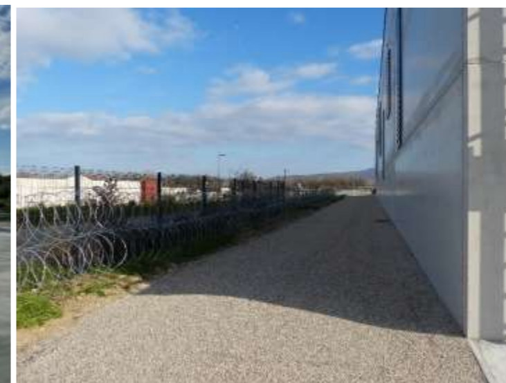
Plateforme SOLUWASTE : accès pompiers côté nord des bâtiments (cliché IATE 01/23)
