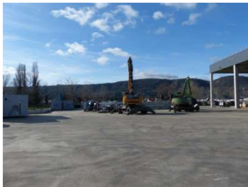
Plateforme SOLUWASTE : vue générale de l'aire bétonnée (cliché IATE 01/23)
