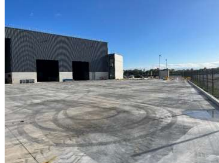
Plateforme SOLUWASTE : bâtiment partie totalement fermée vue depuis l'aire bétonnée de stockage des déchets vers l'entrée du site (cliché TS 09/22)
