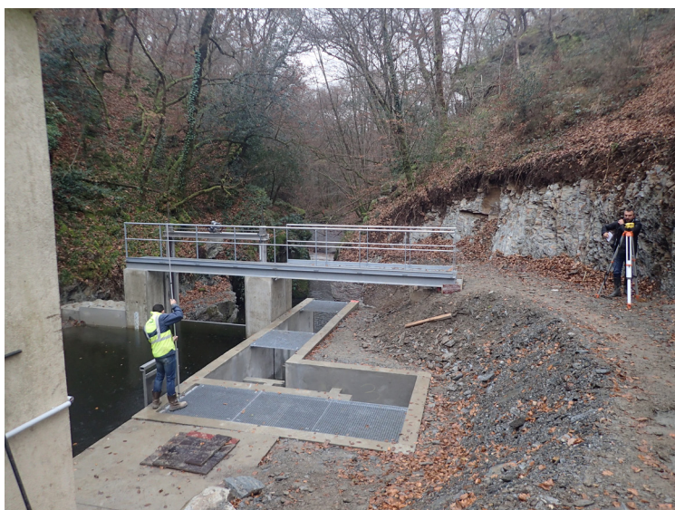
Photo 5 : Finalisation du projet : pose de la passerelle et des caillebotis sur la passe à poisson (24/11/2017)
