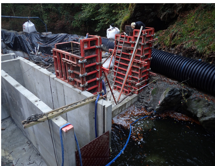
Photo 3 : Mise en place des structures en béton armé qui accueilleront la vanne levante (13/10/2017)
