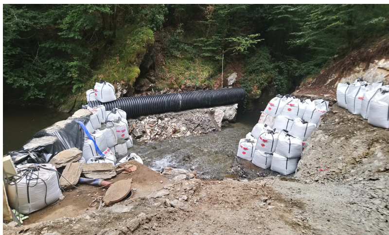
Photo 1 : Installation du Batardeau (08/09/2017)
