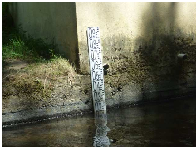
Échelle limnimétrique installée contre le bâtiment du captage (16/07/2015)
