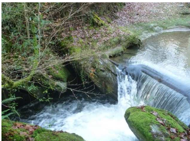
Vue du seuil et de la chute en eaux moyennes (25/01/2016)
