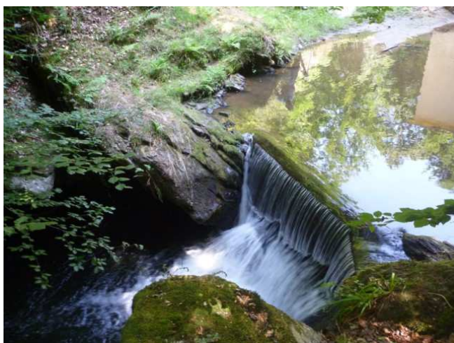
Vue du seuil et de la chute en basses-eaux (16/07/2015)
