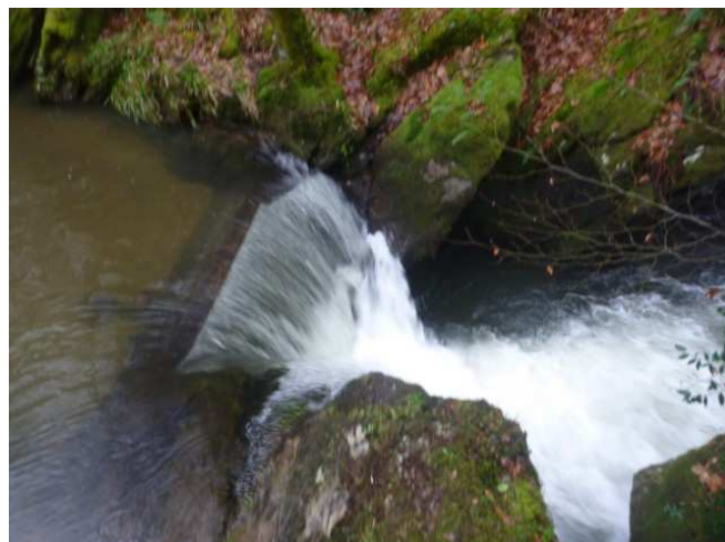
Vue du seuil et de la chute en hautes-eaux (22/02/2016)
