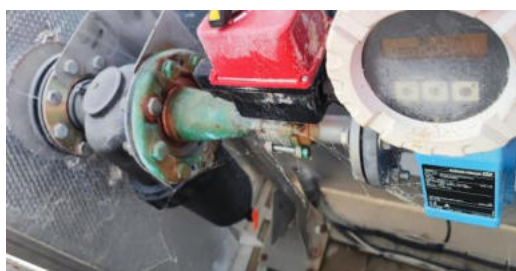
Réduction sur ligne perméat à remplacer
