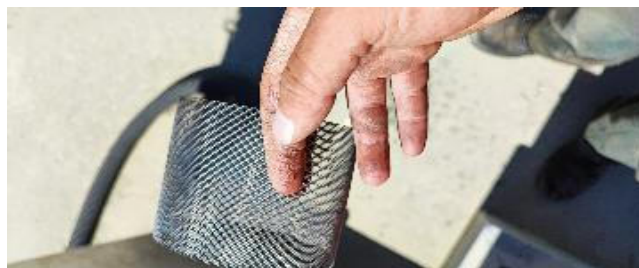
Contrôle du filtre de l'électrovanne de sécurité
