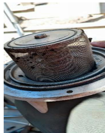
Contrôle et nettoyage du filtre de l'électrovanne de sécurité
