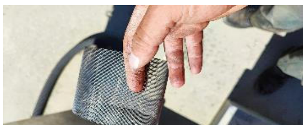
Contrôle du filtre de l'électrovanne de sécurité
