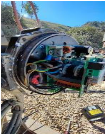
Servomoteur remplacé
