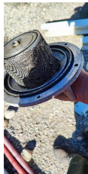
Contrôle et nettoyage du filtre de l'électrovanne de sécurité
