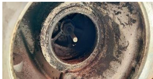
Contrôle siège du clapet de l'électrovanne
