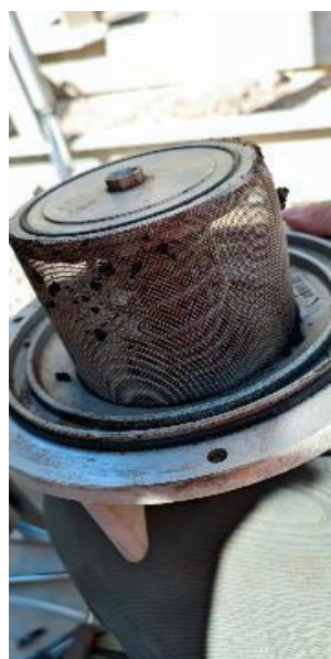
Contrôle et nettoyage du filtre de l'électrovanne de sécurité
