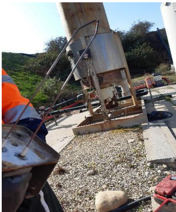
Contrôle électrodes
