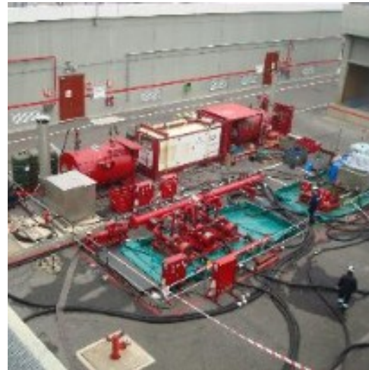
Activité de nettoyage chimique d'infrastructure industrielle
