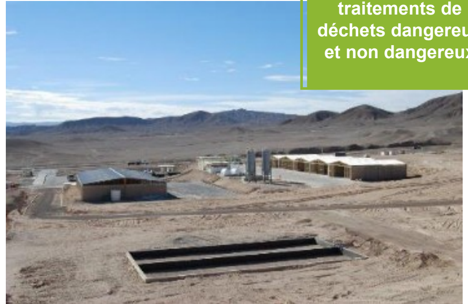
Site de stockage de déchets dangereux de Sierra Gorda, dans le désert d'Atacama au Chili.
