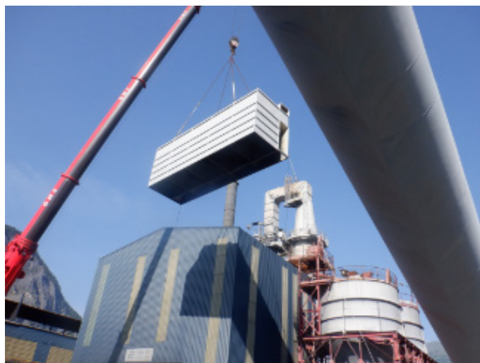
Changement du filtre du Centre de Traitement des Fumées du four à cuire - été 2021
