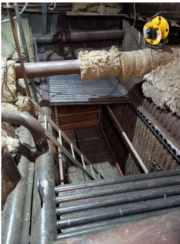
Remplacement toit parcours T3
