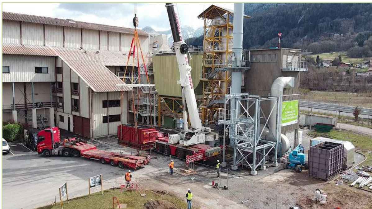
Usine de Valorisation Énergétique des déchets ménagers du SIVOM de la Région de CLUSES 27/06/2022
