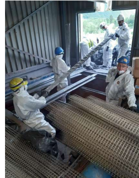
Remplacement des manches du FAM
