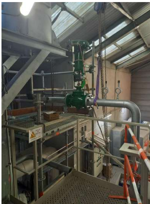
Installation vanne de démarrage
