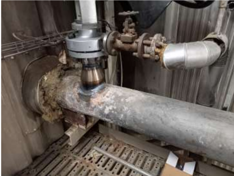
Remplacement vanne de désurchauffe vapeur HP
