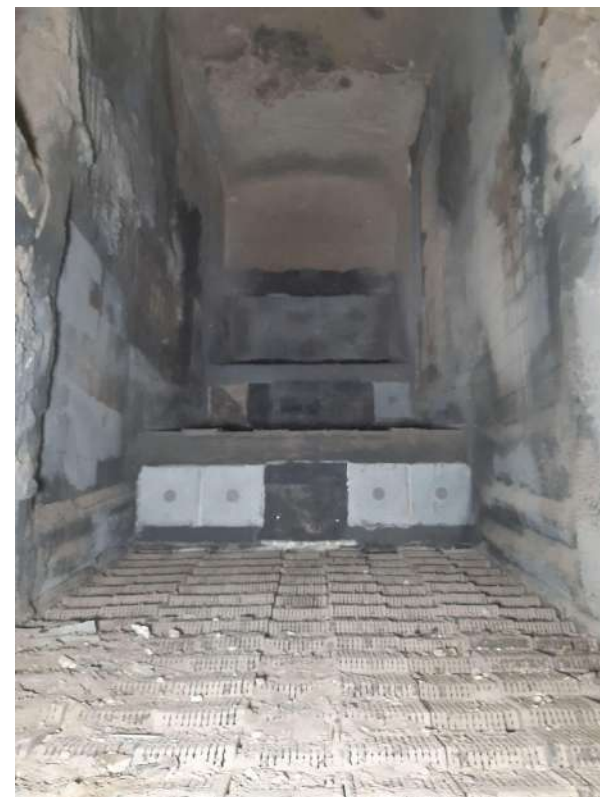
travaux de fumisterie
