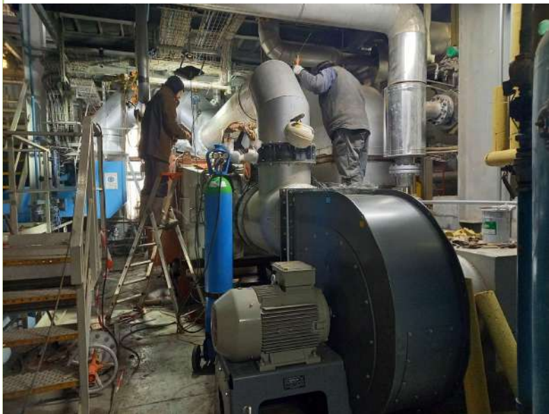
Raccordement réchauffeur d'air + remplacement ventilateur Air Primaire
