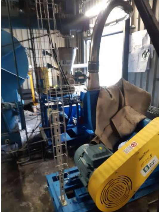
Remplacement du broyeur bicarbonate N°1
