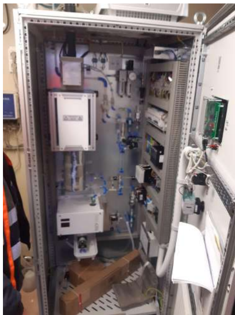
Installation analyseur mercure
