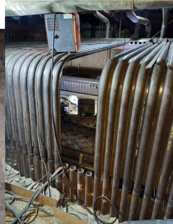
Décennale chaudière + remplacement toit du parcours T2
