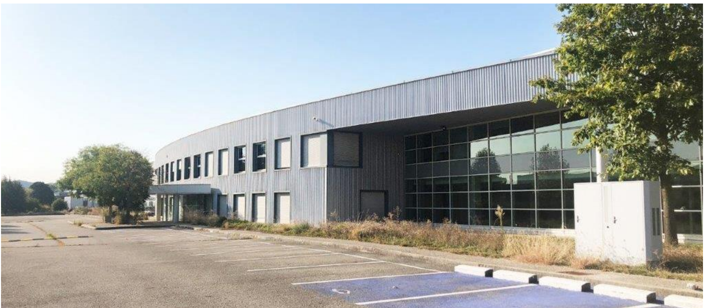
Vues du bâtiment principal depuis le parking situé au sud (rue des Prés Seigneurs) vers le nord-ouest (à gauche sur la photo du bas) qui passe en bordure sud (mai 2022).
