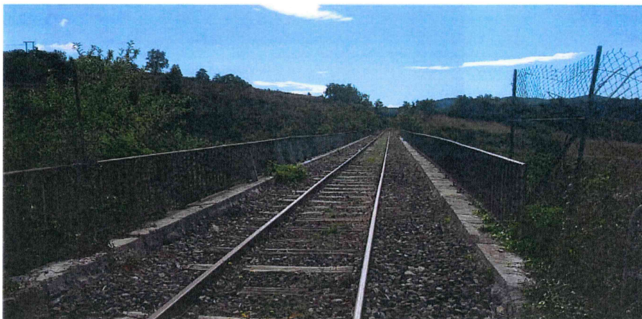
Photo 7 : viaduc de Vobiscon
