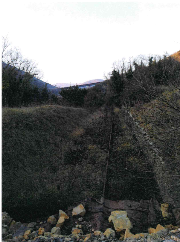
Photo 2 : à proximité de la future aire d'accueil du Pontet (près du pont de l'actuelle RN 102 sur le Frayol)
