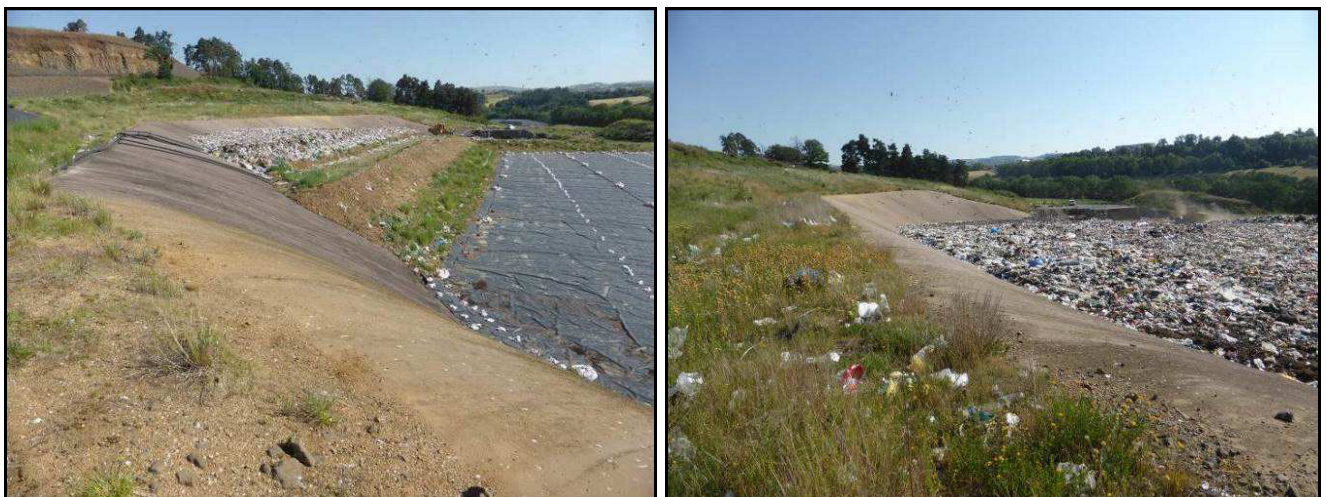
Vue sur le casier 2 et l'alvéole en exploitation de l'ISDND des Cramades à Saint-Flour (mai 2017)
