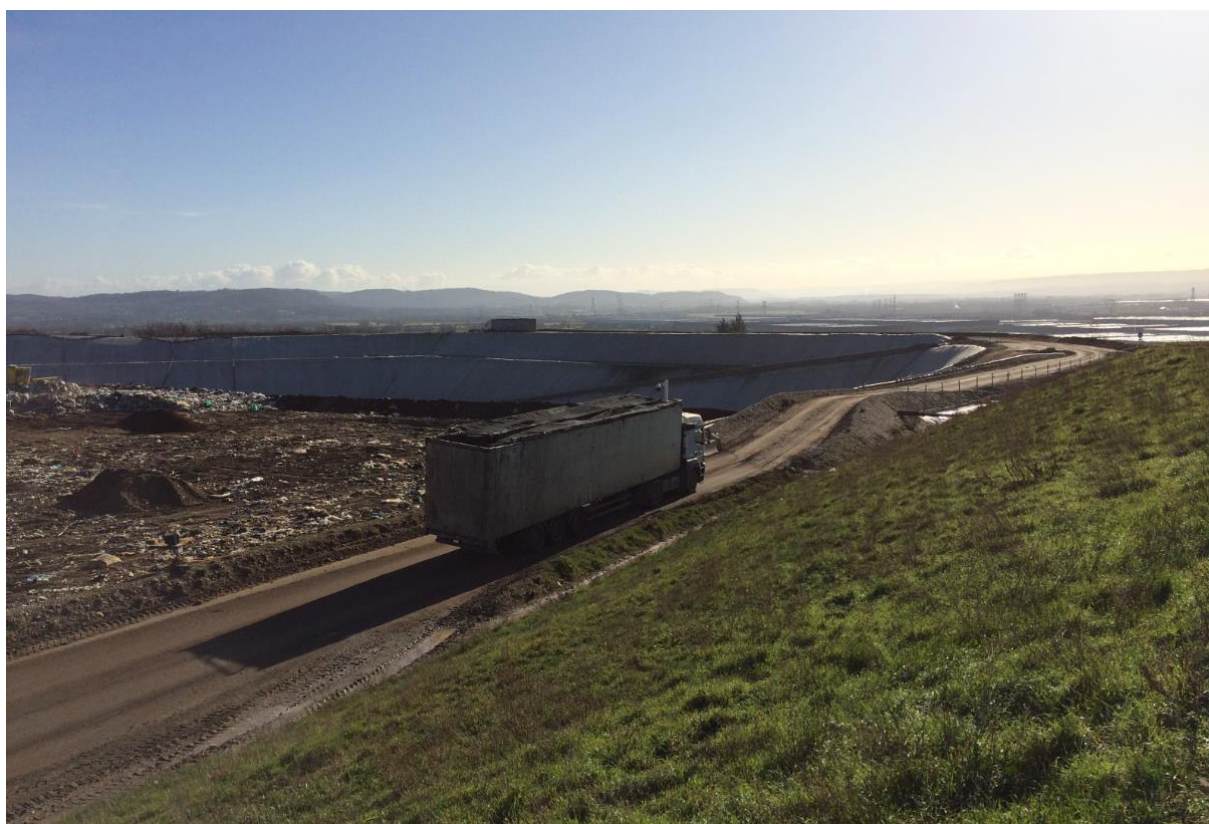
Figure 32 : Vue n°5 : limite Satolas 3/Satolas 2 (Source : EKOS 12/02/2020)
