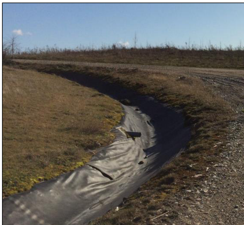
Figure 18 : Fossé pluvial et sortie de drain sur Satolas 1 (Source : EKOS 12/02/2020)
