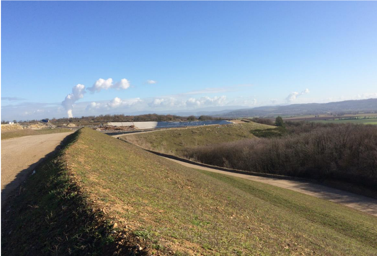
Figure 33 : Vue n°6 – Est : Talus en limite de site et arbres le masquant (Source : EKOS 12/02/2020)
